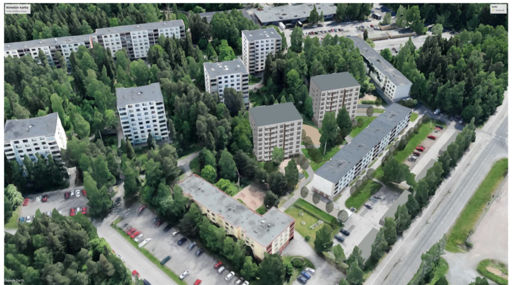
Kuva 8. Valokuvasovituksessa uudet pistetalot ja ympäristön rakennuksia luoteen suunnasta
