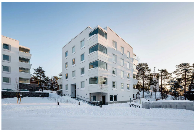
Täydennysrakentamista 1960–70-lukujen asuinalueelle: Kyösti Kallion tie 1, Kulosaari, Helsinki; suunnitellut Kirsti Sivén & Asko Takala Arkkitehdit Oy. Sopusuhtaiset pistetalot istuvat kauniisti kallioiseen maisemaan.
