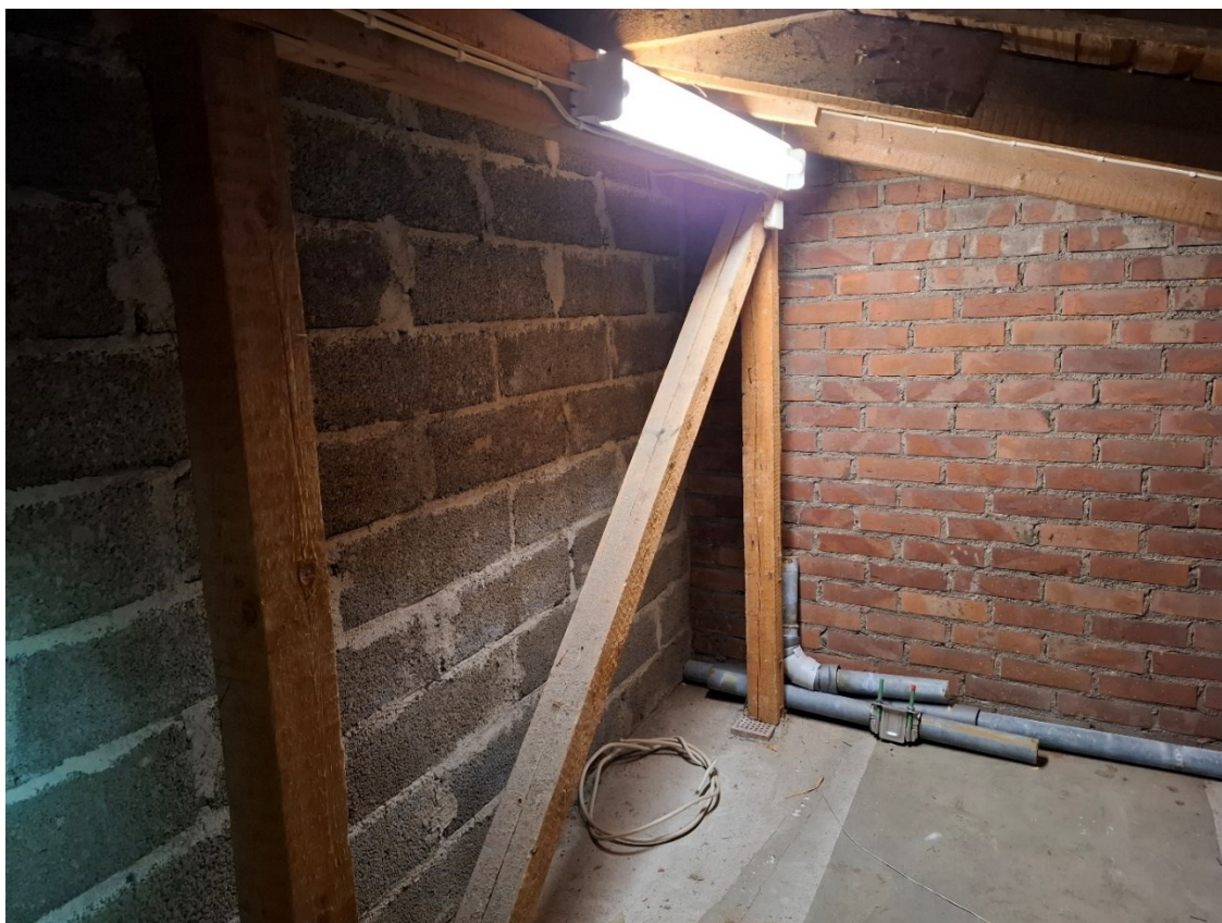
Kuva 4-1. Ullakon varastotilan seinämä. Seinämän vierestä lattialta ei löytynyt lepakoiden esiintymisestä kertovia papanoita.
