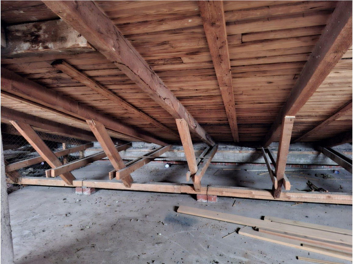
Kuva 4-2. Varastotilan katon puurakenteita.
