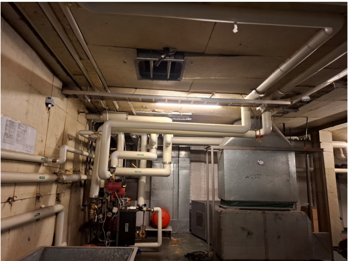
Kuva 4-3. Ilmanvaihtokonehuone, joka ei ole lepakoille potentiaalinen elinympäristö.
