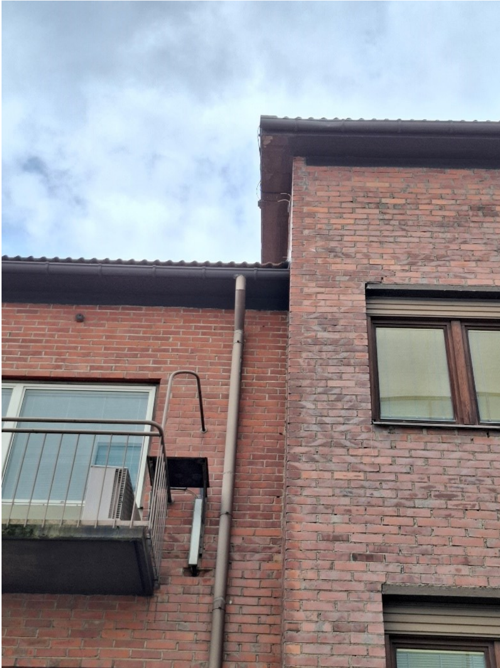
Kuva 3-2. Västäräkin pesä sijaitsee kattotiilien alla, eikä pesä ollut ulkoapäin näkyvillä.
