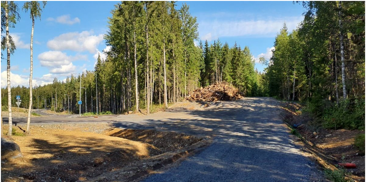
Kuva 7. Aluetta länsiosassa halkova metsätie, jonka vasemmalla puolella on rakenteilla olevaa aluetta (selvitysalueen ulkopuolella)
