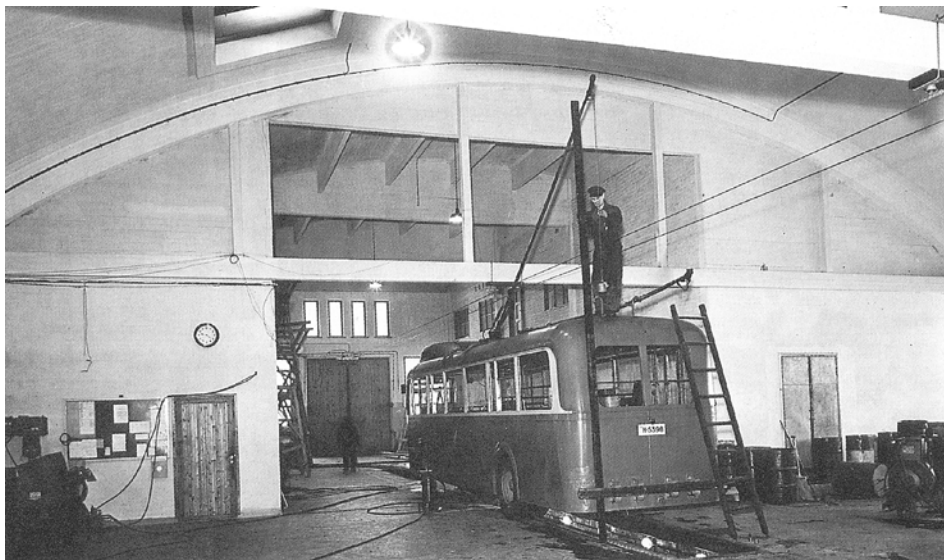
Johdinauto huollettavana pohjoisemman sisäänajon yhteydessä olevalla korjauskuopalla vuonna 1950. E.M. Staff, Tampereen museoiden kuva-arkisto / Peltola 1998.
