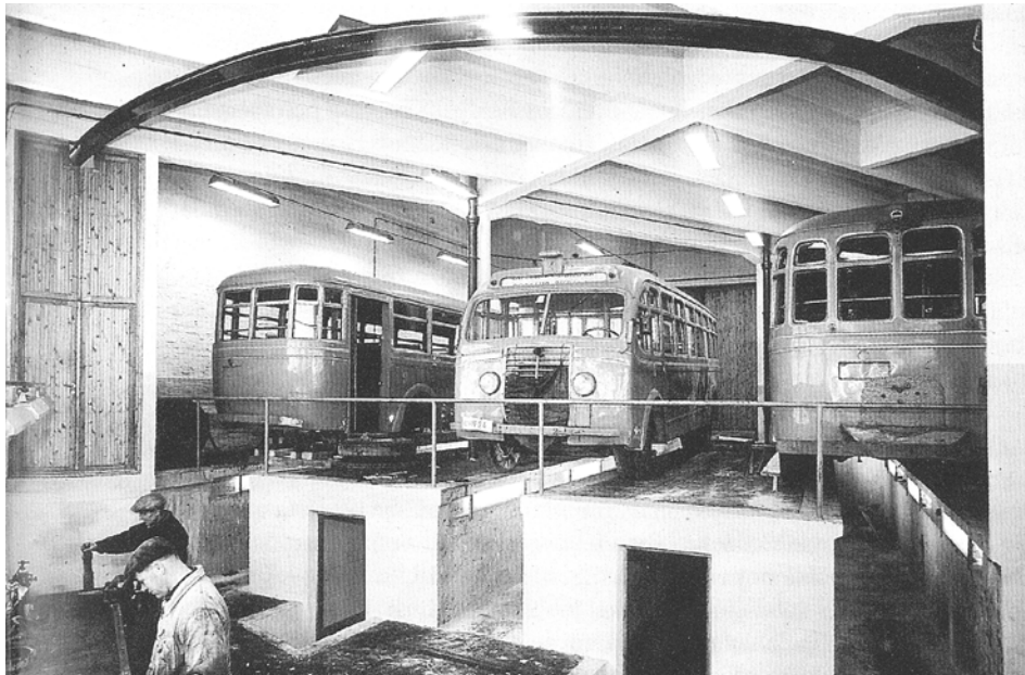
Autoja korjattavana siipiosan korjauskuopilla. Autot ajettiin korjaamoon varsinaisen hallin puolelta kuvan taustalla näkyvistä ovista. E.M. Sfaf, Tampereen museoiden kuva-arkisto / Peltola 1998.
