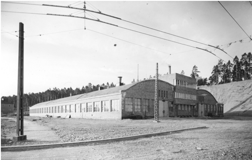
Näkymä luoteesta. Johdinlangat jatkuivat varsinaiselta runkolinjalta hallin pihalle ja torniosan molemmilla puolilla oleville parioville, joiden kautta autot ajettiin sisään halliin. Kuvan oikeassa reunassa harjun rinne on vielä täysin puuton. E.M. Staf, Vapriikin kuva-arkisto, TM. Ajoitusaika-arvio 1950.
