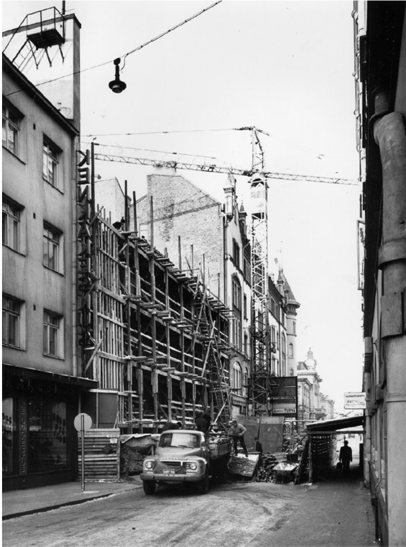
Yllä rakennustyömaa talvella 1964-1965, kuvassa edellisvuoden Bedford TJ 5ton 214/300cid bensakuormuri , jota valmistettiin aina 80-luvun puoliväliin asti. Tamperen työväenmuseon arkisto.
