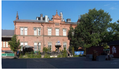
Tullikamari ja pakkahuone Georg Schreck (1901) sr-18
