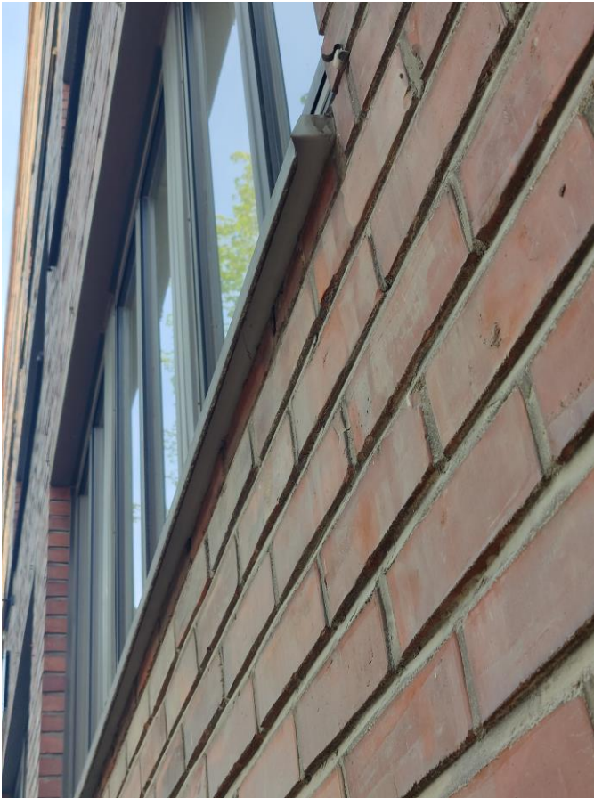
Kuva 5. Rakennuksen ikkunalaudat ja räystäät ovat kiikareilla katsottuna pääosin tiiviit, eikä ikkunalautojen tai räystäiden alla havaittu lintujen pesintään soveltuvia koloja, mitä esimerkiksi kadun toiselle puolelle sijoittuvassa rakennuksessa havaittiin. Räystäiden eikä ikkunalautojen alla tai kadulla havaittu lintujen suurempia ulostekerääntymiä, jotka viittaisivat pesiin.
