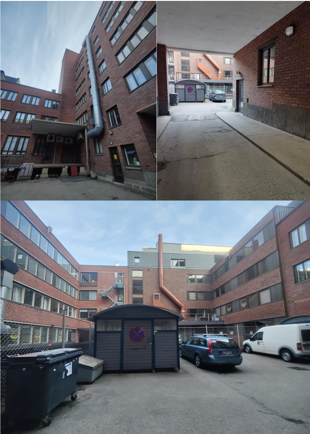
Kuva 2. Sisäpiha. Ylemissä kuvissa on rakennuksen eteläseinä ja sisäänkäynti sisäpihalle. Alemmassa kuvassa on näkymä kiinteistön sisäpihalta etelään. Sisäpihalla ei ole puustoa, istutuksia tai kasvikattoja, jotka tarjoaisivat ravintoa linnuille.
