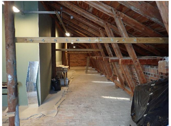
Kuva 29 Vesikattorakenteet ullakolta kuvattuna.
