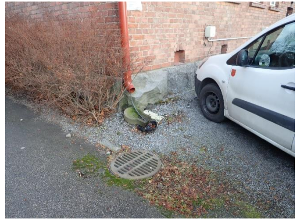
Kuva 10 Kattovedet ohjataan syöksytorvien ja loiskivien avulla sadevesikaivoihin.
