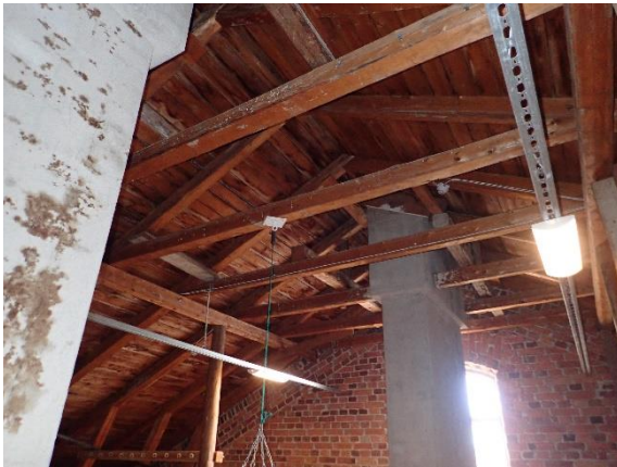
Kuva 28 Vesikattorakenteet ullakolta kuvattuna.
