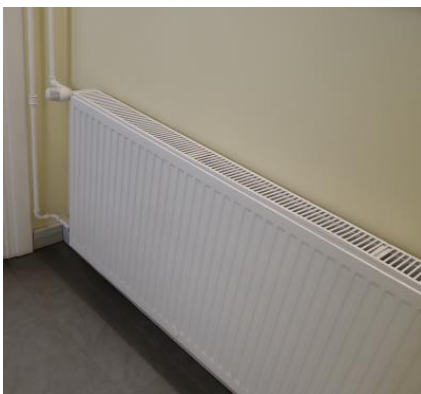
Kuva 40 Teräslevypatteri vuodelta 2012.
