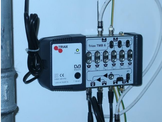
Kuva 79 Yleiskuva antennivahvistimesta.
