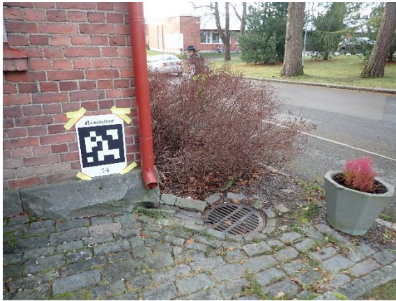
Kuva 9 Kattovedet ohjataan syöksytorvien ja loiskivien avulla sadevesikaivoihin.
