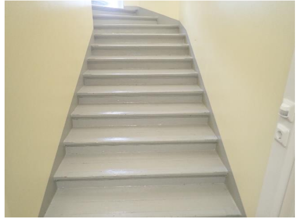
Kuva 18 Ensimmäisen ja toisen kerroksen väliset puurakenteiset portaat.
