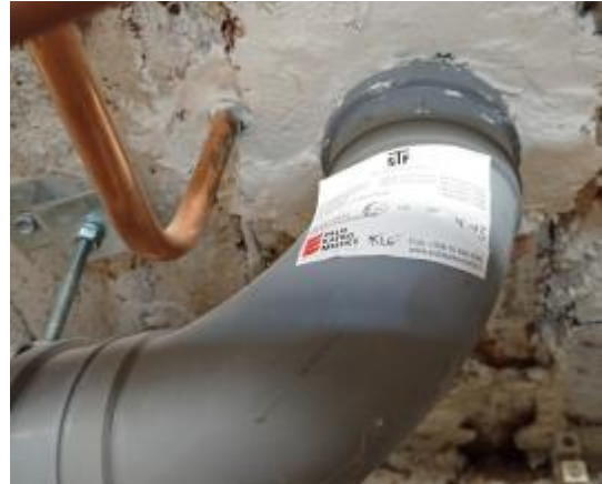
Kuva 47 Saneerauksen yhteydessä asennettu muoviviemäri.
