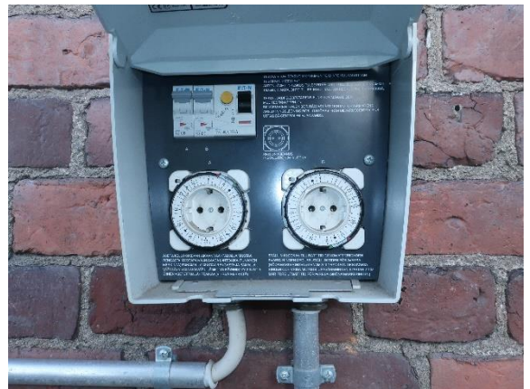
Kuva 70 Yleiskuva autolämmityspistorasiasta.
