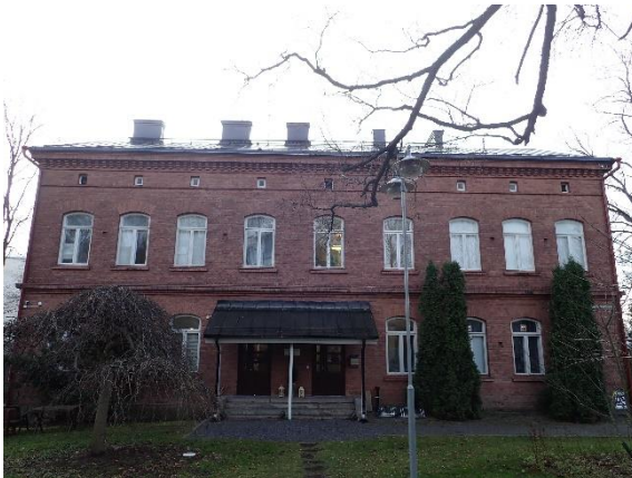
Kuva 19 Yleiskuvaa rakennuksen julkisivuista.
