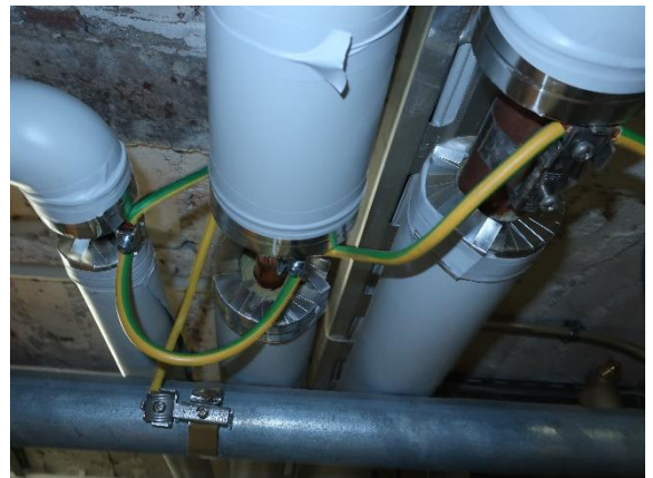
Kuva 64 Yleiskuva putkistomaadoituksesta.
