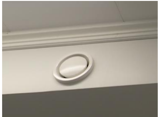
Kuva 56 Poistoilmaventtiili.
