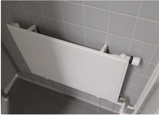
Kuva 42 Käsikäyttöpyörällä varustettu teräslevypatteri.
