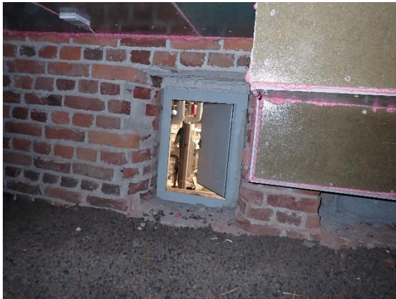
Kuva 13 Ryömintätilan kulkuluukku.
