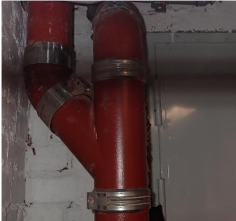
Kuva 46 Saneerauksen yhteydessä asennettuja valurautaviemäreitä.
