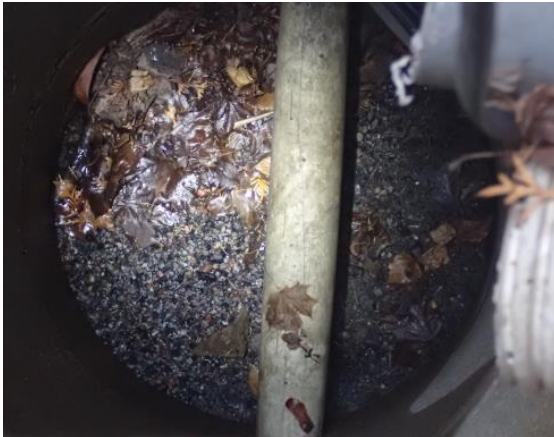
Kuva 48 Näkymä rakennuksen luoteiskulmalla olevaan vanhaan betoniseen sadevesikaivoon.
