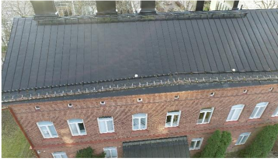
Kuva 26 Kopterikuvaa rakennuksen vesikatosta.
