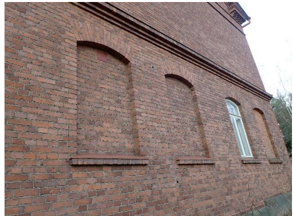
Kuva 20 Yleiskuvaa rakennuksen julkisivuista.
