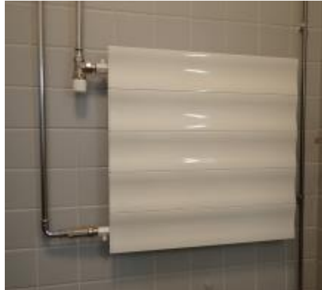
Kuva 51 Käyttövesipatteri.
