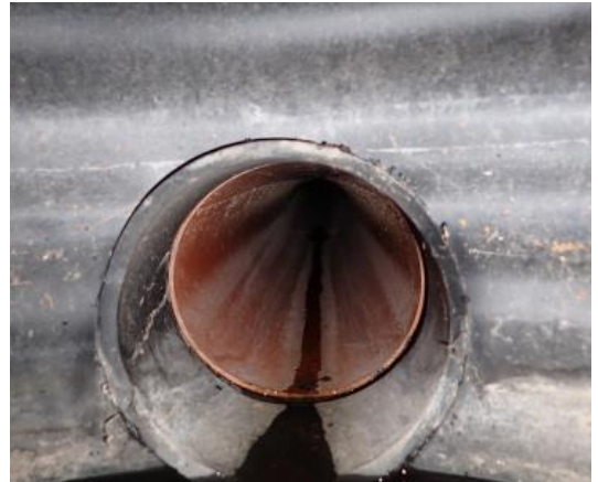
Kuva 49 Rakennuksen eteläsivulla olevaan muoviseen sadeveden tarkastuskaivoon johtava muovinen sadevesiviemäri.
