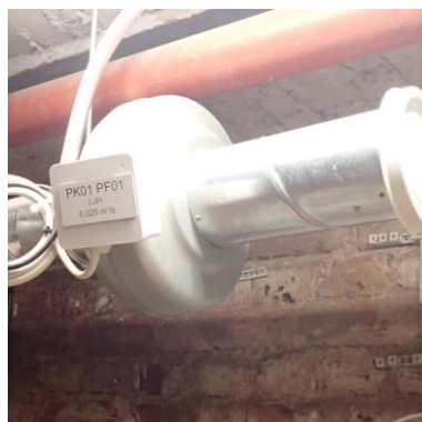
Kuva 53 Lämmönjakohuoneen poistoilmapuhallin.
