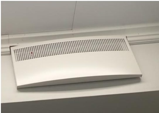
Kuva 55 Tuloilmapäätelaite.
