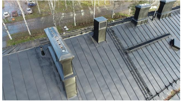
Kuva 27 Kopterikuvaa rakennuksen vesikatosta.
