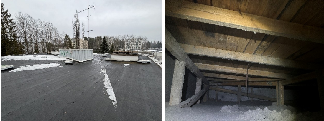
Kuva 16 a-b. a) Yleiskuva vesikatolta. b) Yleiskuva yläpohjatilasta.
