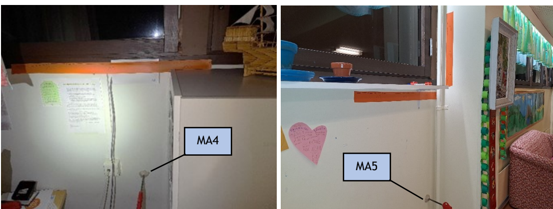
Kuva 9 a-b. Merkkiaineen syöttökohdat MA4 ja MA5 kellarikerroksen maanvastaisten seinien eristetilään. Merkkiainekokeissa havaittiin ikkunaliitoksista merkittäviä vuotoja. Kuvissa havaitut vuotokohdat on merkitty oransseilla teipeillä.
