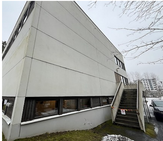
Kuva 29 a-b. Yleiskuvia etelä- ja länsijulkisivuista. Eteläisivulla on teräsbetonirakenteinen porras, joka on asetettu käyttökieltoon (kuva b).
