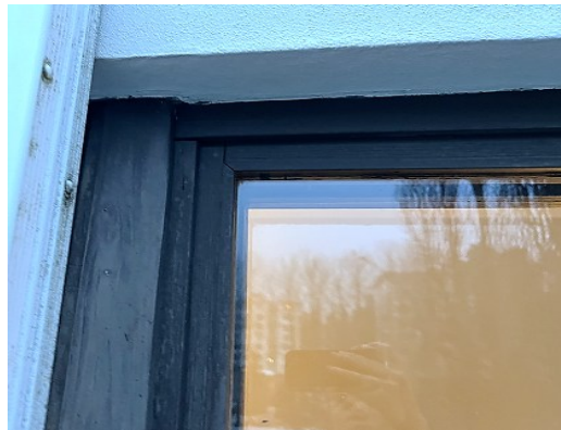
Kuva 50 a-d. Pohjakerroksen ikkunat sekä yleisesti kaikkien ikkunoiden yläosat ovat ulkopuitteiden ja karmien osalta paremmassa kunnossa.
