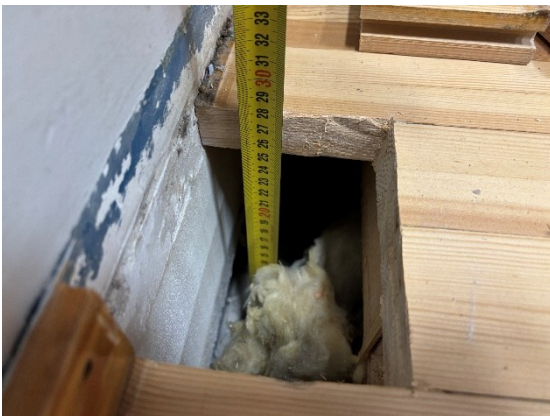
Kuva 13. 1. kerroksen salin puulattian rakenneavaus RA-VP4.
