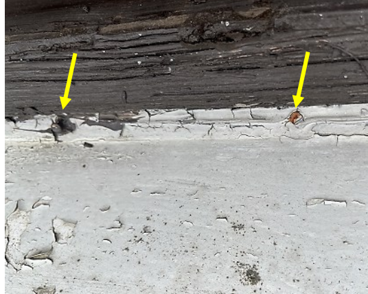
Kuva 54 a-b. Ikkunoiden vesipellit on kiinnitetty naulaamalla karmiin ja niiden yläreunat on viety karmihuullokseen alle. Vesipeltien maali hilseilee ja pellit ovat likaantuneita. Naulakiinnikkeissä on korroosiota ja osa nauloista on noussut pois puun sisältä (kuva b).
