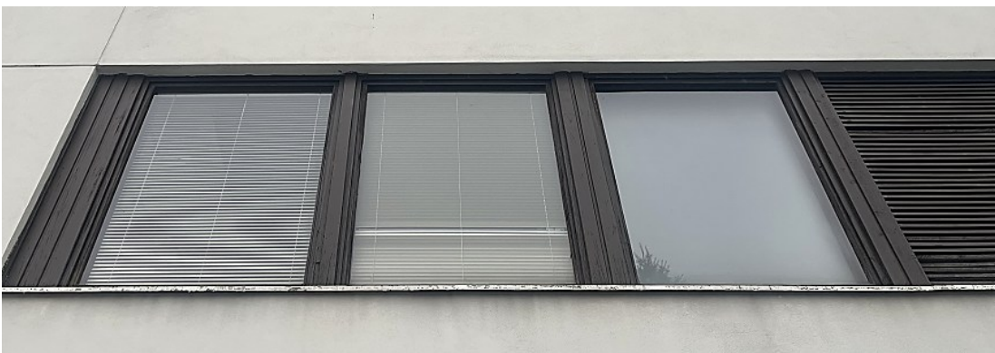
Kuva 46. Yleiskuva 1. ja 2. kerroksen korkeammista ikkunoista ulkopuolelta.
