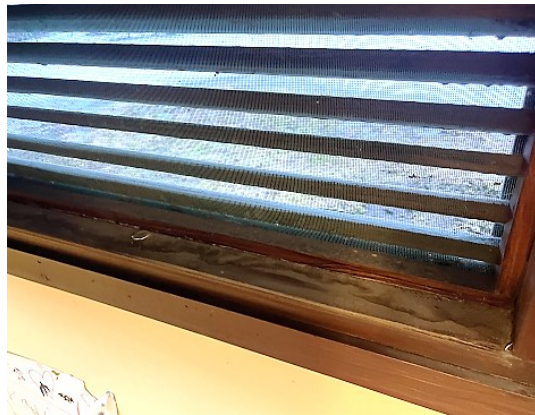
Kuva 52 a-d. Tuuletusikkunoiden ulkopinnoissa ja karmiväleissä havaittiin jonkin verran vanhoja kosteusjälkiä ja muilta osin lähinnä suojapinnoitteen haalistumista. Puuosissa ei tarkastelluilta osin havaittu lahovaurioita.
