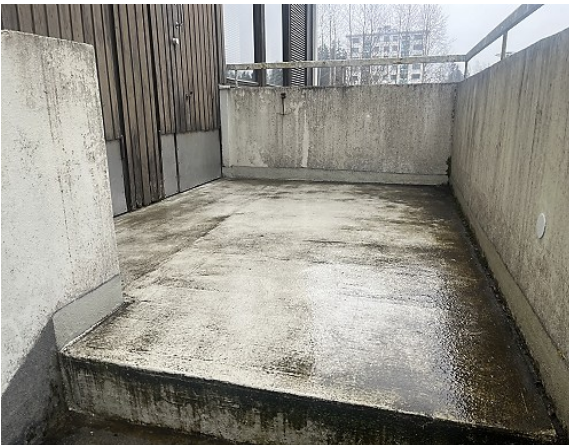
Kuva 38 a-b. Ylätasanteelta ei ole hallittua vedenpoistoa. Ylätasanteen, portaan ja kaiteiden pinnat ovat likaantuneita.
