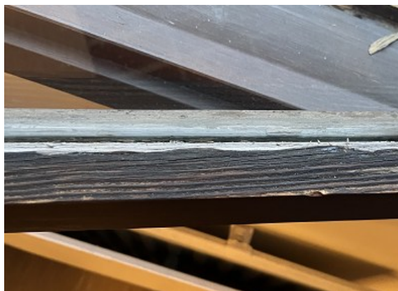
Kuva 51 a-b. Sisäpuitteet hyvässä tai tyydyttävässä kunnossa ja niissä havaittiin pääosin pintakäsittelyn haalistumista ja paikoin puupinnan halkeilua (kuva b).
