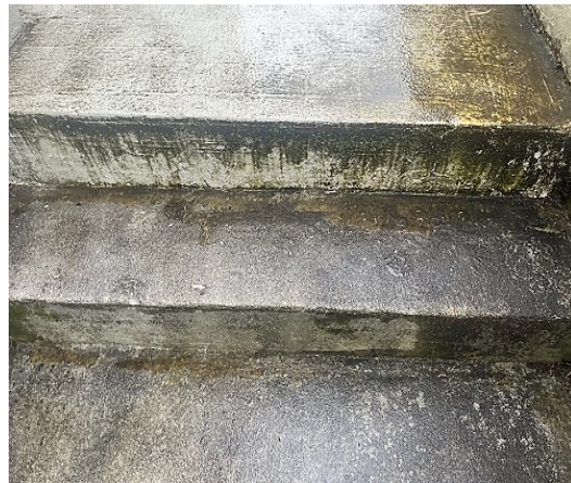
Kuva 38 a-b. Ylätasanteelta ei ole hallittua vedenpoistoa. Ylätasanteen, portaan ja kaiteiden pinnat ovat likaantuneita.
