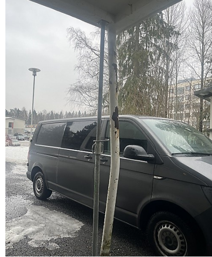
Kuva 37 a-b. Käytöstä poistetut portaan laastipinnoilla on verkkomaista halkeilua ja portaan alaosan nurkkakohdassa myös paikallista betonin rapautumaa (kuva a). Porrasta kannatteleva, vääntynyt teräspilari on tuettu holvitueella (kuva b).
