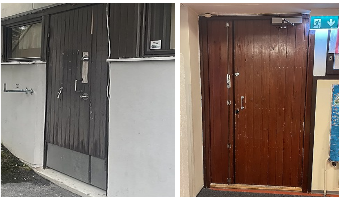
Kuva 60 a-b. Eteläsivun puupaneloitu ulko-ovi pohjakerroksessa, yleiskuvia ulko- ja sisäpuolelta.
