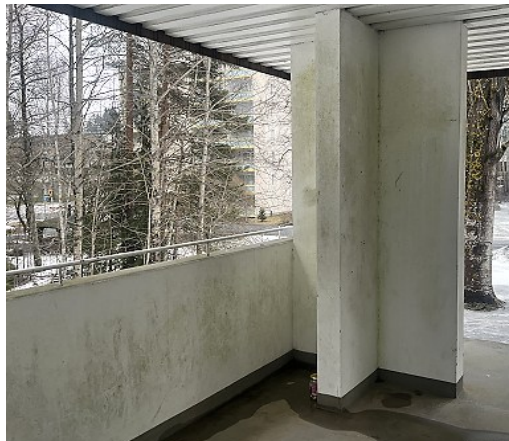
Kuva 33 a-b. Laatalta ei ole järjestetty hallittua vedenpoistoa, joten vedet lammikoituvat laatan pinnalle. Kaitteiden pinnat ovat likaantuneita.
