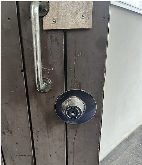
Kuva 61 a-d. Eteläsivun puupaneloitu ulko-ovi pohjakerroksessa. Oven lakkapinnat ovat paikoin kuluneita ja ulkopuolen pintakäsittely haalistunut. Oven karmin liitoksissa seinään ja alakattoon havaittiin maali- ja tasoitepinnan vaurioita (kuva b).
