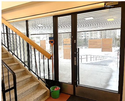
Kuva 55 a-b. Itäisivun sisäänkäynnin teräsrakenteinen ulko-ovi, yleiskuvia ulko- ja sisäpuolelta.
