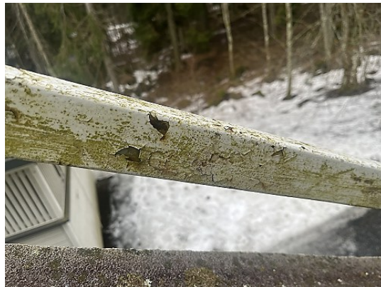
Kuva 39 a-b. Laatan alapinnassa on halkeilua ja näkyviä terästen korroosioaurioita (kuva a). Kaiteen käsijohteen teräsosista on hilseillyt maali altistaen rakenteen korroosiolle (kuva b).
