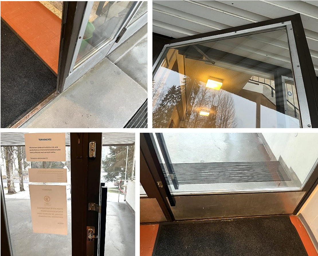
Kuva 56 a-d. Itäsvun sisäänkäynnin teräsrakenteinen ulko-ovi. Oven ulko- ja sisäpinnat ovat tyydyttävässä kunnossa.
