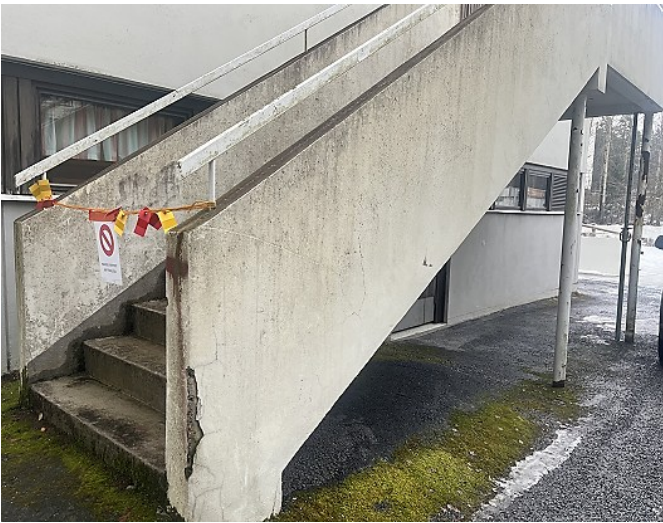
Kuva 37 a-b. Käytöstä poistetut portaan laastipinnoilla on verkkomaista halkeilua ja portaan alaosan nurkkakohdassa myös paikallista betonin rapautumaa (kuva a). Porrasta kannatteleva, vääntynyt teräspilari on tuettu holvitueella (kuva b).
