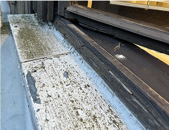
Kuva 54 a-b. Ikkunoiden vesipellit on kiinnitetty naulaamalla karmiin ja niiden yläreunat on viety karmihuullokseen alle. Vesipeltien maali hilseilee ja pellit ovat likaantuneita. Naulakiinnikkeissä on korroosiota ja osa nauloista on noussut pois puun sisältä (kuva b).
