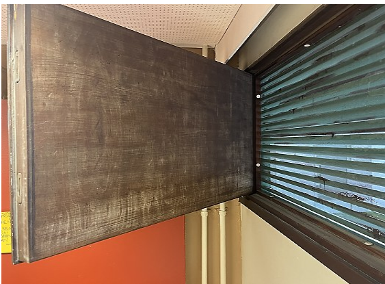
Kuva 52 a-d. Tuuletusikkunoiden ulkopinnoissa ja karmiväleissä havaittiin jonkin verran vanhoja kosteusjälkiä ja muilta osin lähinnä suojapinnoitteen haalistumista. Puuosissa ei tarkastelluilta osin havaittu lahovaurioita.
