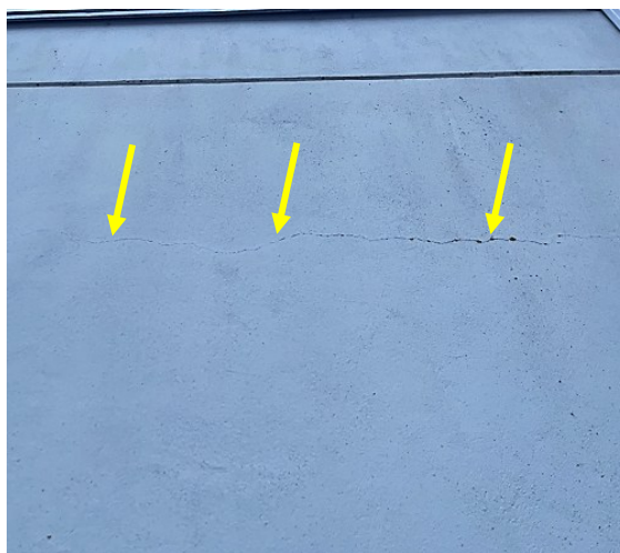
Kuva 30 a-b. Umpielementeissä havaittuja pitkiä vaakahalkeamia eteläisivulla (kuva a) ja itäisivulla (kuva b) rakennuksen yläosissa.
