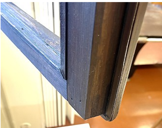
Kuva 53 a-b. Ikkunoiden sisäpuitteiden tiivistysnauhat ovat litistyneet muodottomiksi (kuva a). Ulkopuiteiden muoviset stopparit ovat monin paikoin rikki tai irronneet kokonaan (kuva b).
