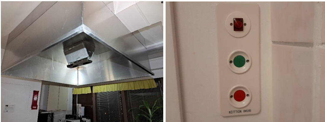
Kuva 68 a-b. a) 1. kerroksen keittiön huuva. b) Keittiön poistoilmanvaihdon kytkimet oven vieressä ovat ilman ohjeita niiden käytöstä.
