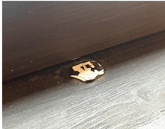
Kuva 53 a-b. Ikkunoiden sisäpuitteiden tiivistysnauhat ovat litistyneet muodottomiksi (kuva a). Ulkopuiteiden muoviset stopparit ovat monin paikoin rikki tai irronneet kokonaan (kuva b).
