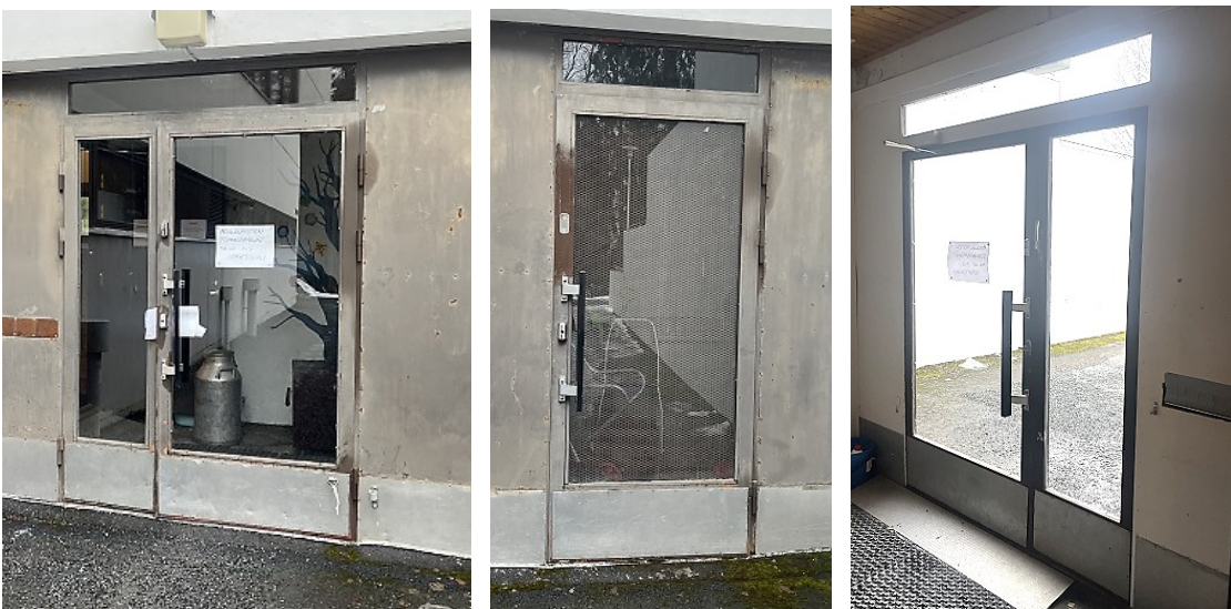
Kuva 57 a-c. Eteläsvun sisäänkäynnin teräsrakenteiset ulko-ovet, yleiskuvia ulko- ja sisäpuolelta.
