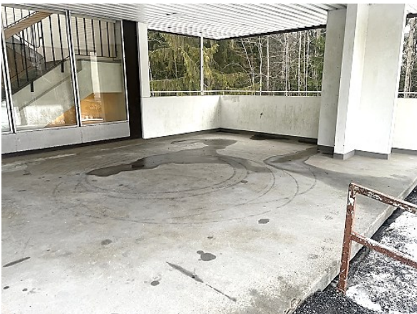
Kuva 33 a-b. Laatalta ei ole järjestetty hallittua vedenpoistoa, joten vedet lammikoituvat laatan pinnalle. Kaitteiden pinnat ovat likaantuneita.
