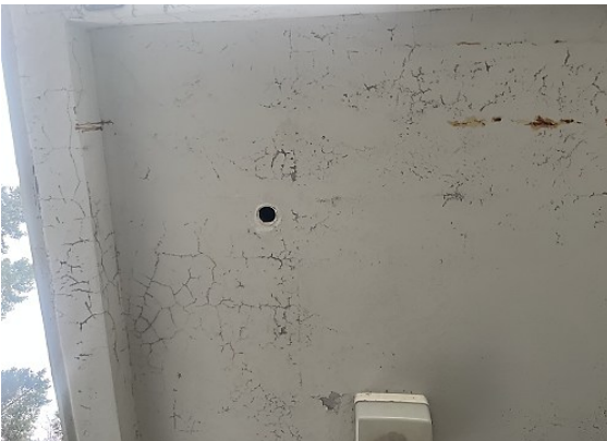
Kuva 39 a-b. Laatan alapinnassa on halkeilua ja näkyviä terästen korroosioaurioita (kuva a). Kaiteen käsijohteen teräsosista on hilseillyt maali altistaen rakenteen korroosiolle (kuva b).
