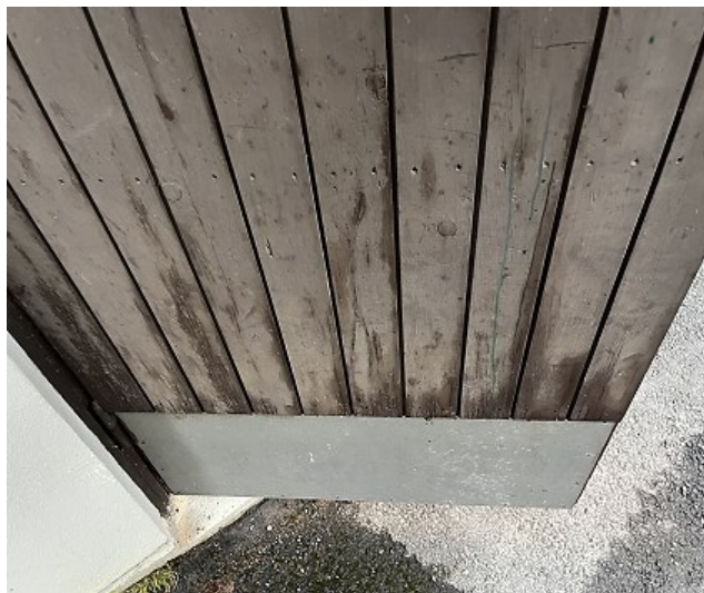
Kuva 61 a-d. Eteläsivun puupaneloitu ulko-ovi pohjakerroksessa. Oven lakkapinnat ovat paikoin kuluneita ja ulkopuolen pintakäsittely haalistunut. Oven karmin liitoksissa seinään ja alakattoon havaittiin maali- ja tasoitepinnan vaurioita (kuva b).
