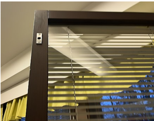
Kuva 51 a-b. Sisäpuitteet hyvässä tai tyydyttävässä kunnossa ja niissä havaittiin pääosin pintakäsittelyn haalistumista ja paikoin puupinnan halkeilua (kuva b).
