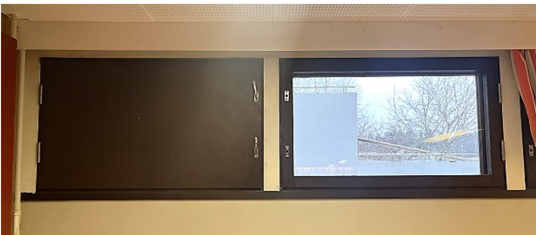
Kuva 43. Yleiskuva pohjakerroksen matalammista ikkunoista sisäpuolelta.
