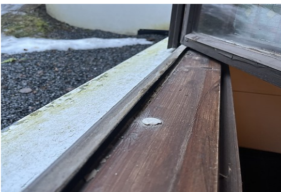
Kuva 50 a-d. Pohjakerroksen ikkunat sekä yleisesti kaikkien ikkunoiden yläosat ovat ulkopuitteiden ja karmien osalta paremmassa kunnossa.
