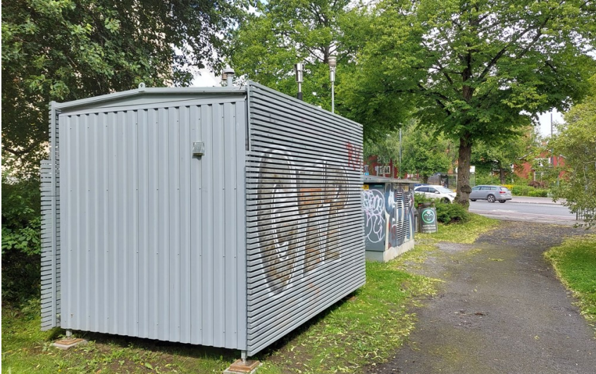
Kuva 1. Pirkankadun mittausasema tilapäisessä sijaintipaikassaan Tredun edustalla Pirkankadun eteläpuolella.
