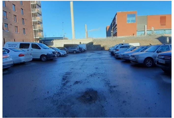
Kuva 2. Edessä kairapisteen 24 kohta asfaltissa.
