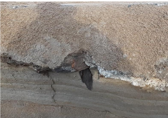
Kuva 11. Koekuopassa 31 oli mm. puuta ja betonikerros.
