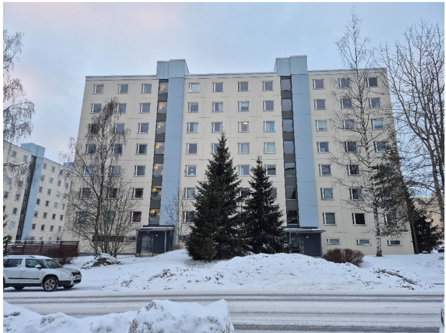
Kuva 8. Suunnittelualueella sijaitseva asuinkerrostalo Ruovedenkadun varrella
