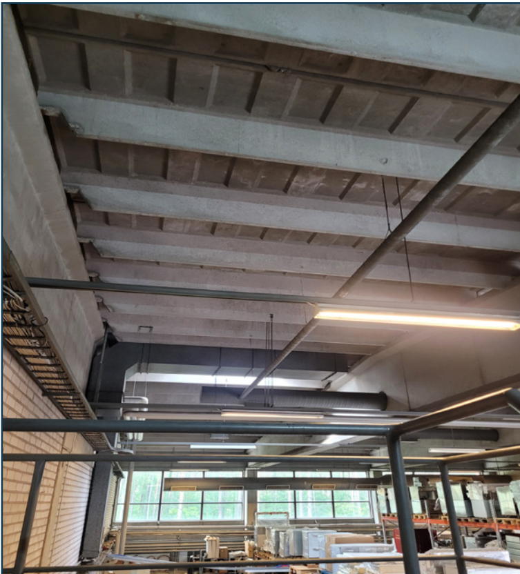
Kuva 3. Hepolamminkatu 9 sisätilojen kattorakenteita.
