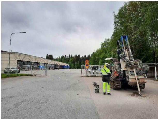
Kuva 18. Kairakone tutkimuspisteellä VAH16 entisellä Valion kiinteistöllä.
