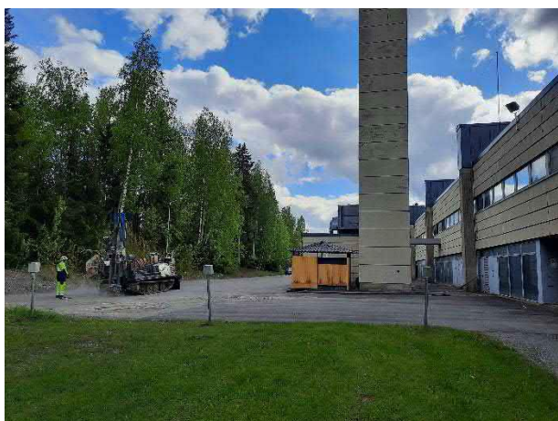
Kuva 22. Tutkimuspiste VAH26, vanha lämpökeskus sekä betonibunkkeri asfalttialueella.
