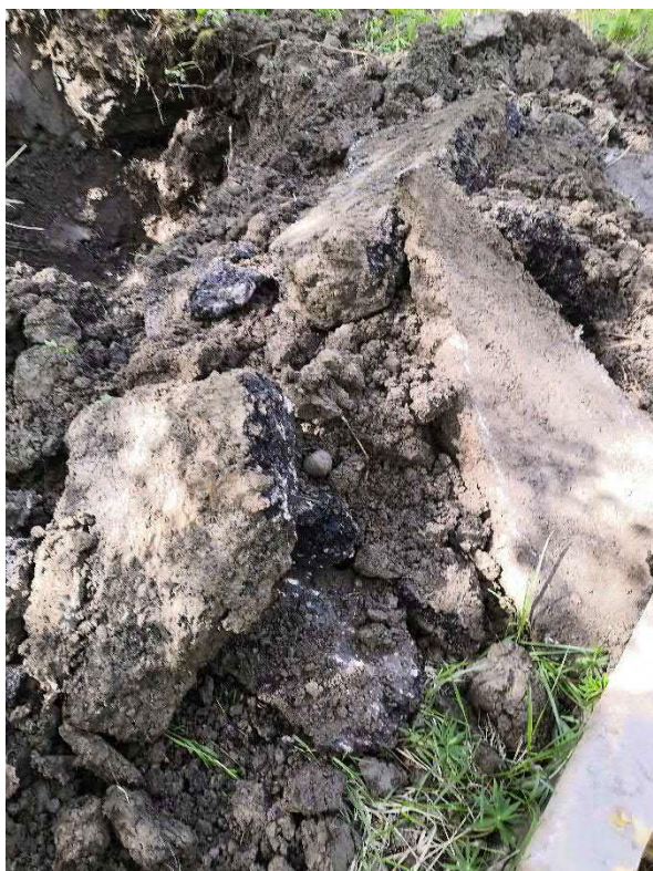
Kuva 17. Koekuopan VAH15 kaivumassoja, jossa asfaltinkappaleita.
