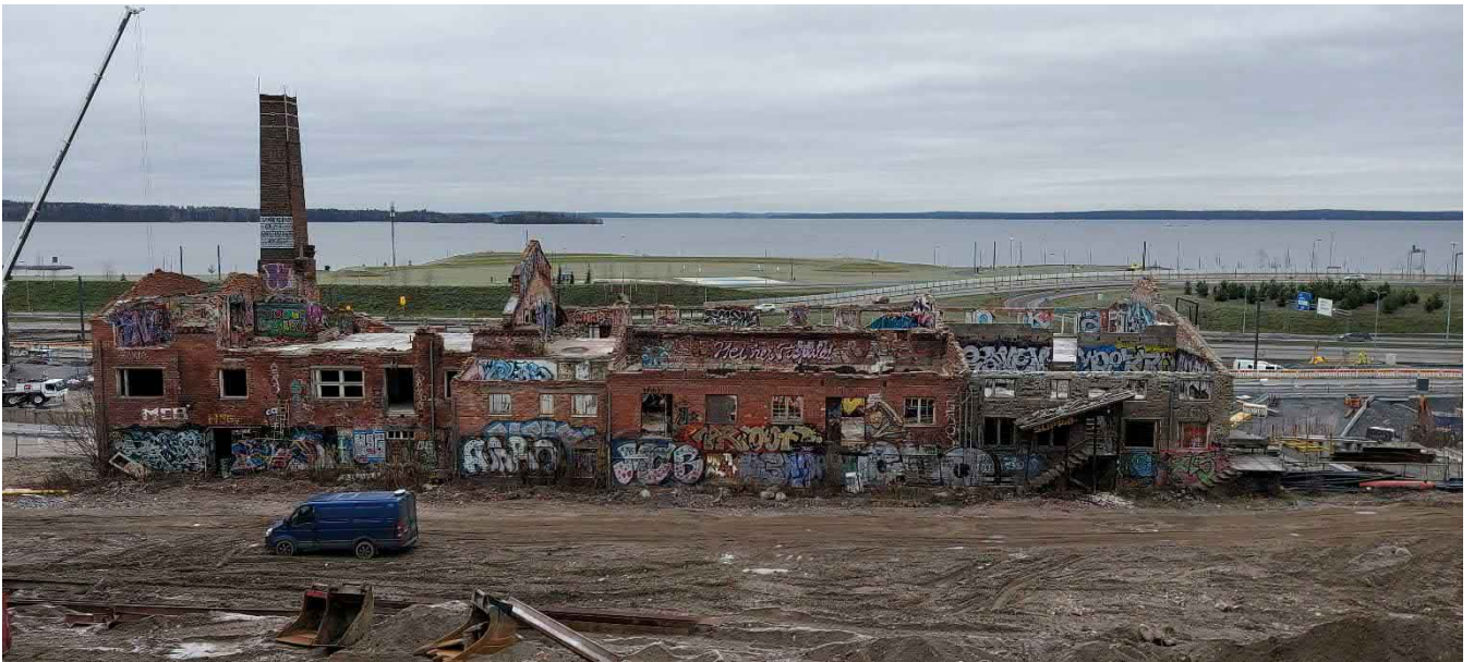
Kuva rakennuksen kunnosta ennen sääsuojan asentamista eteläjulkisivulta.
