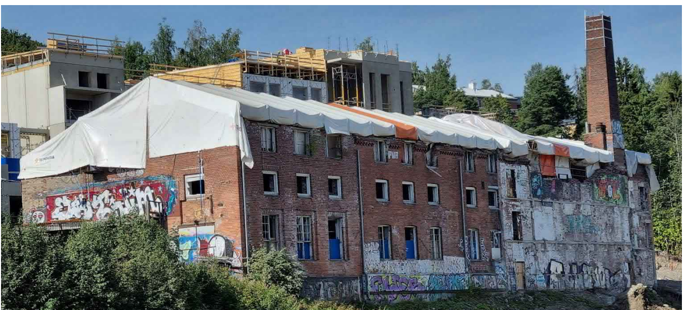
Kuva rakennuksesta sääsuojan asentamisen jälkeen koillisesta.
