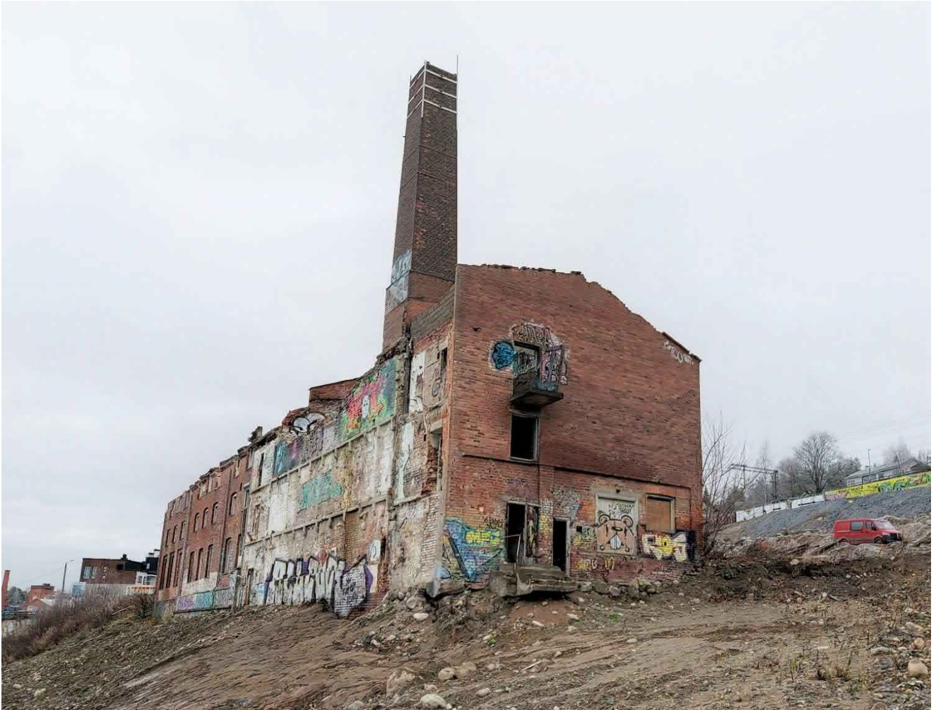
Kuva rakennuksen länsipäädyistä, jossa maaperää on puhdistettu.
