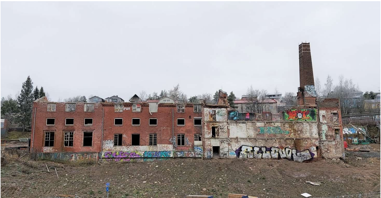
Paperitehtaan pohjoisjulkisivu, kuvattuna 15.11.2021
