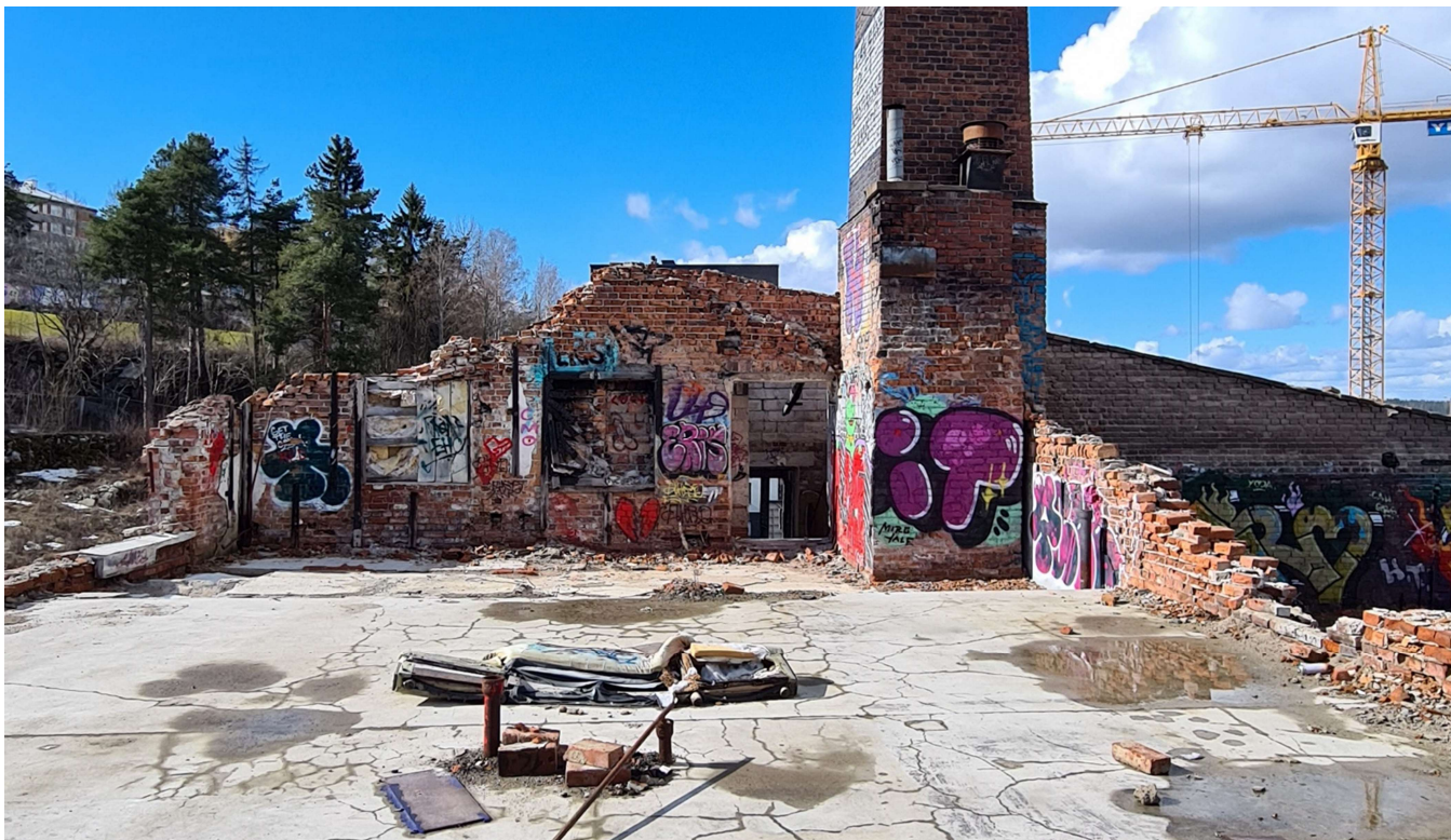
Paperitehtaan ullakon länsipää, kuvattuna länteen 08.04.2021
