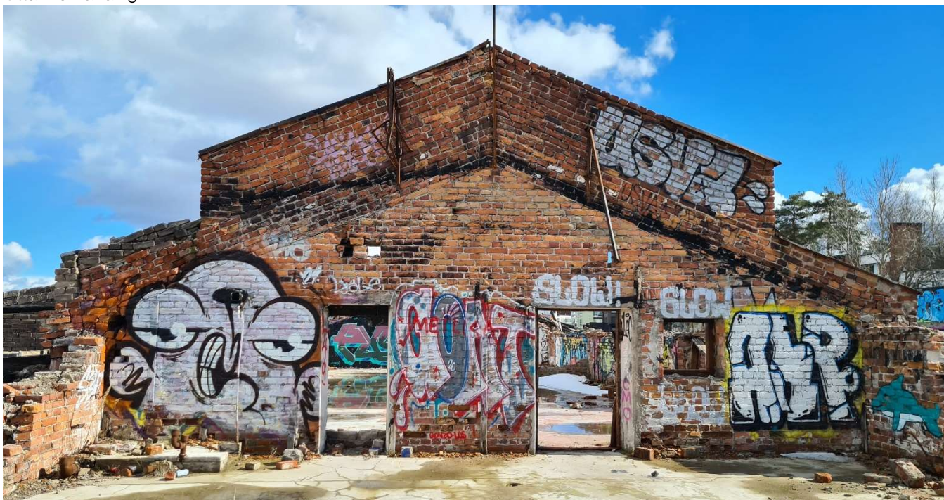
Paperitehtaan ullakon länsipää, kuvattuna itään 08.04.2021
