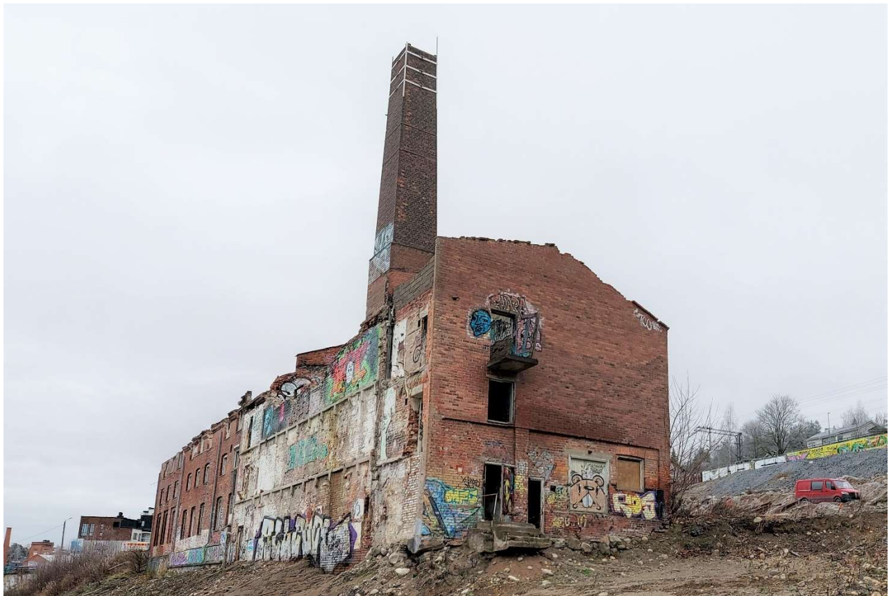
Paperitehtaan luoteiskulma kuvattuna 15.11.2021
