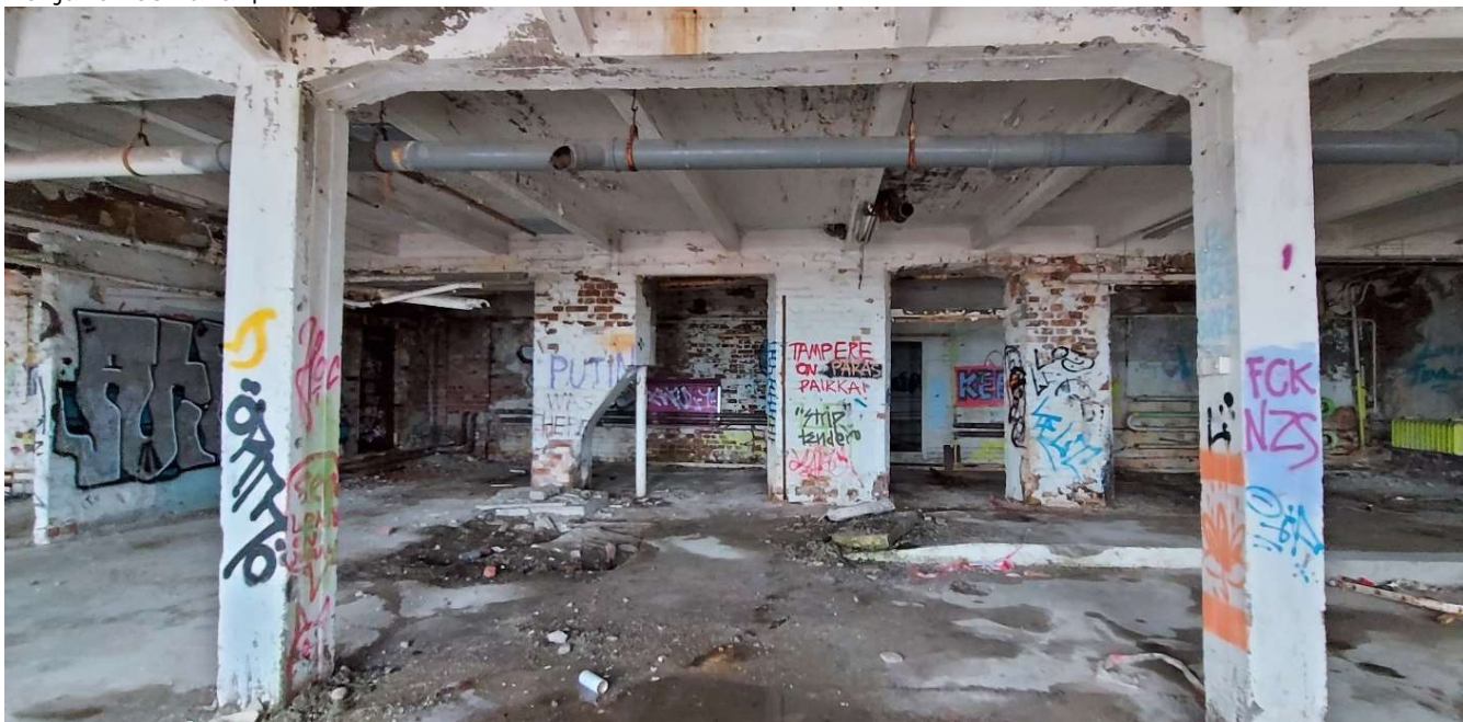
Alkuperäisen paperitehtaan pohjakerroksen itäpääty kohti eteläistä julkisivua, kuvattuna 15.11.2021.
