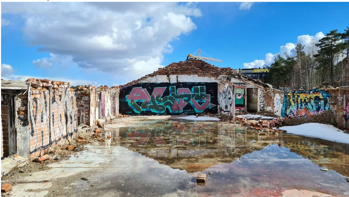
Alkuperäisen paperitehtaan ullakon keskialue kuvattuna itään 08.04.2021
