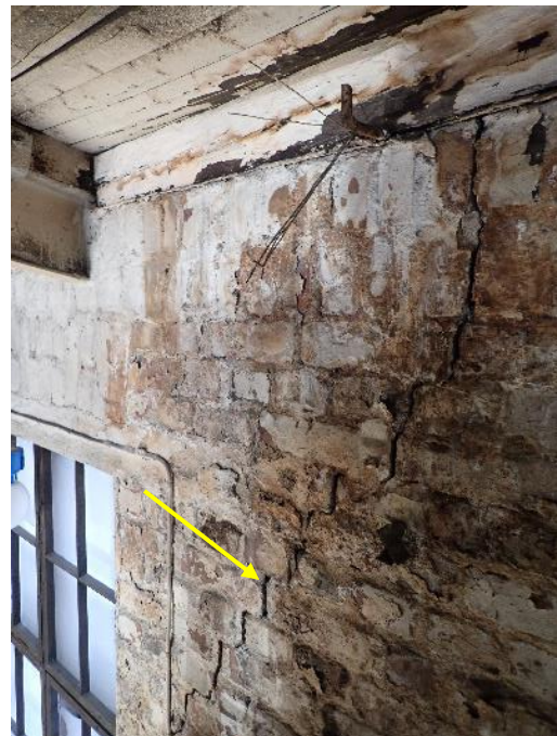
Kuva 12a ja b. Seinäpintojen yläosissa (ulkoseinissä, väliseinissä, seinämäisissä pilareissa, pilastereissa) on paikoin nähtävissä yksittäisiä isompia halkeamia. Esimerkkikuvat pilttuusta 8 (kuva a) sekä 7 (kuvat b ja c).
