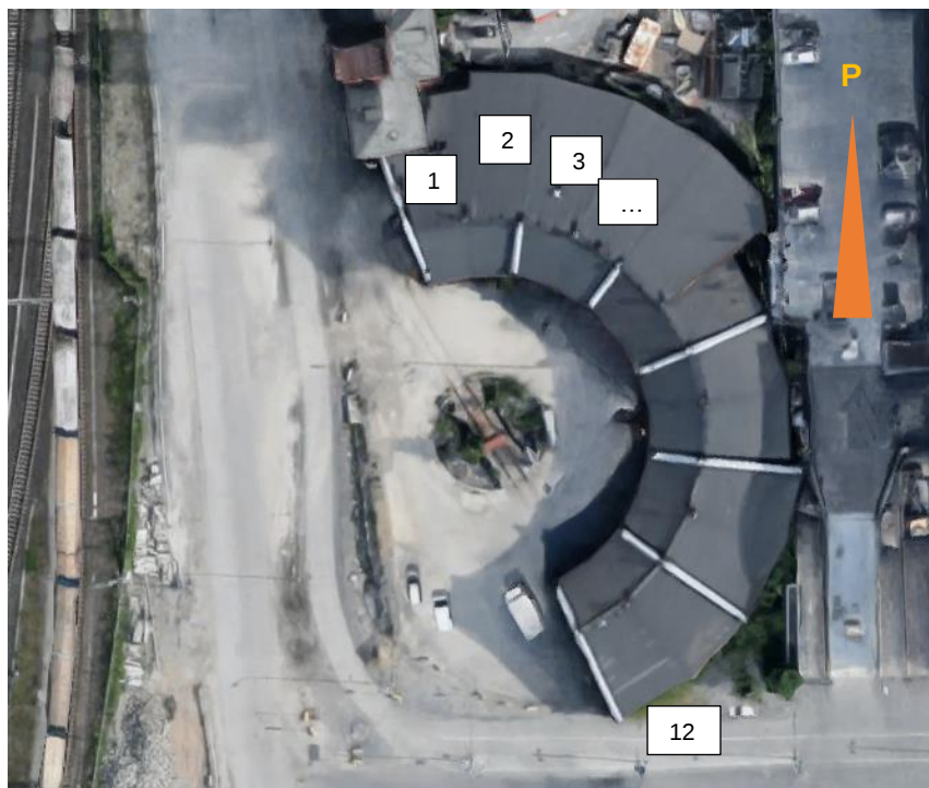
Kuva 1. Eteläinen veturitalli ilmakuvassa. Rakennus koostuu 12 pilttuusta, jotka on numeroitu juoksevasti pohjoisesta alkaen. (Kuva Google 2021)
