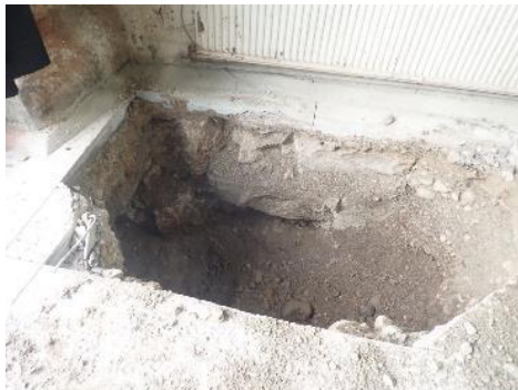
Kuva 17a ja b. Kaivanto 2, rakennusosa vuodelta 1897; pilttuu 3, eteläinen ulkoseinä ja pilttuun 2 puoleinen väliseinä. Tiilimuurin alla on epäsäännöllisiä luonnonkivilohkareita, jotka ulottuvat noin 130 cm syvyyteen lattiapinnasta. Lohkareiden alapuolella on soraa.
