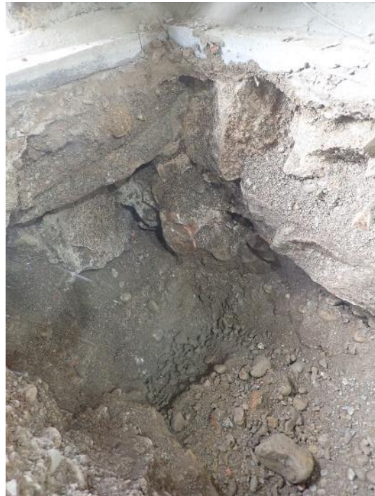
Kuva 17a ja b. Kaivanto 2, rakennusosa vuodelta 1897; pilttuu 3, eteläinen ulkoseinä ja pilttuun 2 puoleinen väliseinä. Tiilimuurin alla on epäsäännöllisiä luonnonkivilohkareita, jotka ulottuvat noin 130 cm syvyyteen lattiapinnasta. Lohkareiden alapuolella on soraa.
