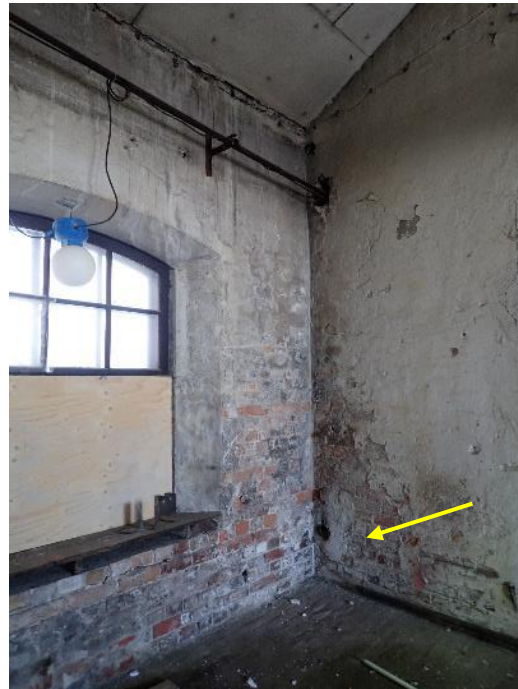
Kuva 15a, b ja c. Ulkoseinien alaosissa on yleisesti nähtävissä pitkäaikaisen kohonneen kosteuden aiheuttamia jälkiä. Esimerkkikuvat pilttuun 8 alakerrasta (kuva a) sekä pilttuista 2 (b) ja 7 (c).
