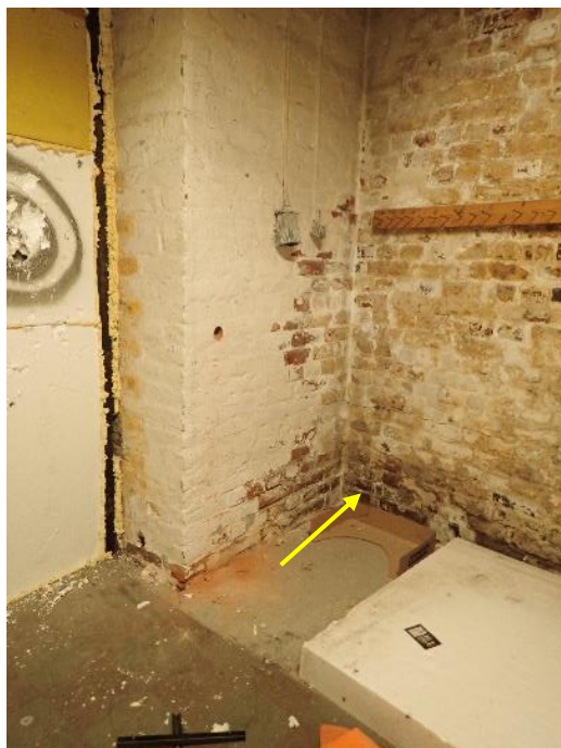
Kuva 15a, b ja c. Ulkoseinien alaosissa on yleisesti nähtävissä pitkäaikaisen kohonneen kosteuden aiheuttamia jälkiä. Esimerkkikuvat pilttuun 8 alakerrasta (kuva a) sekä pilttuista 2 (b) ja 7 (c).
