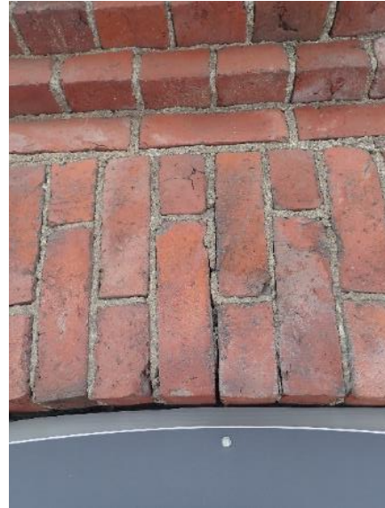
Kuva 9a, b ja c. Ulkokaarteen puolella rakennuksen eteläpäässä esiintyy paikoin yleisesti muurauksen pystysaumojen avonaisuutta ja laastin haurastumista niissä.
