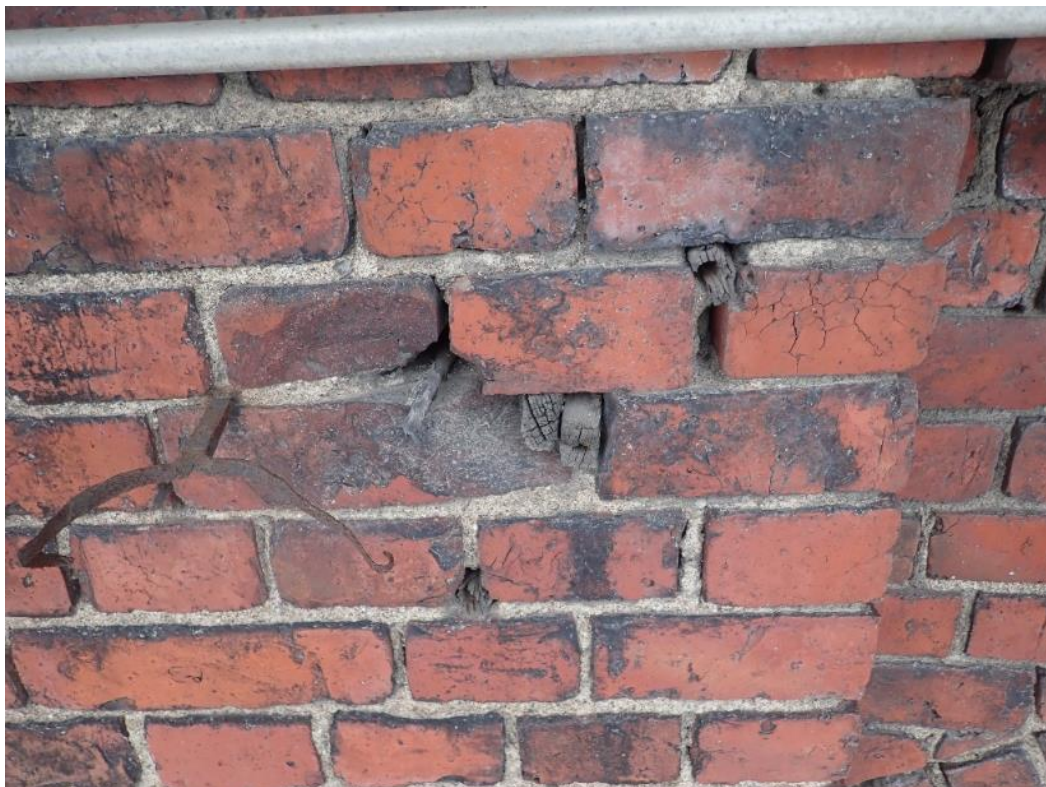
Kuva 6. Pohjoisemman päädyn tiiliräystästä. Laastisaumat ovat paikoin halkeilleet ja rapautuneet. Jäinenkin laasti vaikuttaa paikoin pehmentyneeltä.
