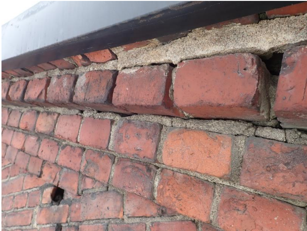
Kuva 6. Pohjoisemman päädyn tiiliräystästä. Laastisaumat ovat paikoin halkeilleet ja rapautuneet. Jäinenkin laasti vaikuttaa paikoin pehmentyneeltä.
