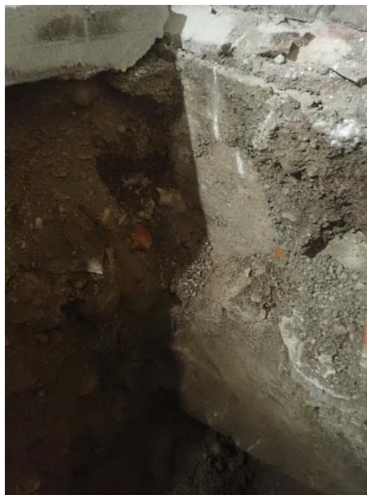
Kuva 16a ja b. Kaivanto 1, rakennusosa vuodelta 1934; pilttuu 3, pohjoinen ulkoseinä ja pilttuun 4 puoleinen väliseinä. Perusmuurin sisäpuoli on betonirakenteinen, betoni jatkuu noin 60 cm lattiatason alapuolelle. Perusmuurin ulkopinta vastaavassa kohdassa on luonnonkiveä. Betonimuurin alla on luonnonkivilohkareita, jotka ulottuvat noin 130 cm syvyyteen lattiapinnasta. Lohkareiden alapuolella on soraa.
