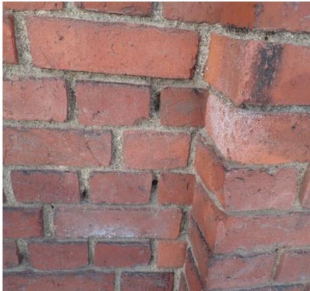
Kuva 9a, b ja c. Ulkokaarteen puolella rakennuksen eteläpäässä esiintyy paikoin yleisesti muurauksen pystysaumojen avonaisuutta ja laastin haurastumista niissä.
