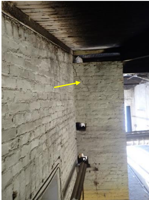
Kuva 12a ja b. Seinäpintojen yläosissa (ulkoseinissä, väliseinissä, seinämäisissä pilareissa, pilastereissa) on paikoin nähtävissä yksittäisiä isompia halkeamia. Esimerkkikuvat pilttuusta 8 (kuva a) sekä 7 (kuvat b ja c).
