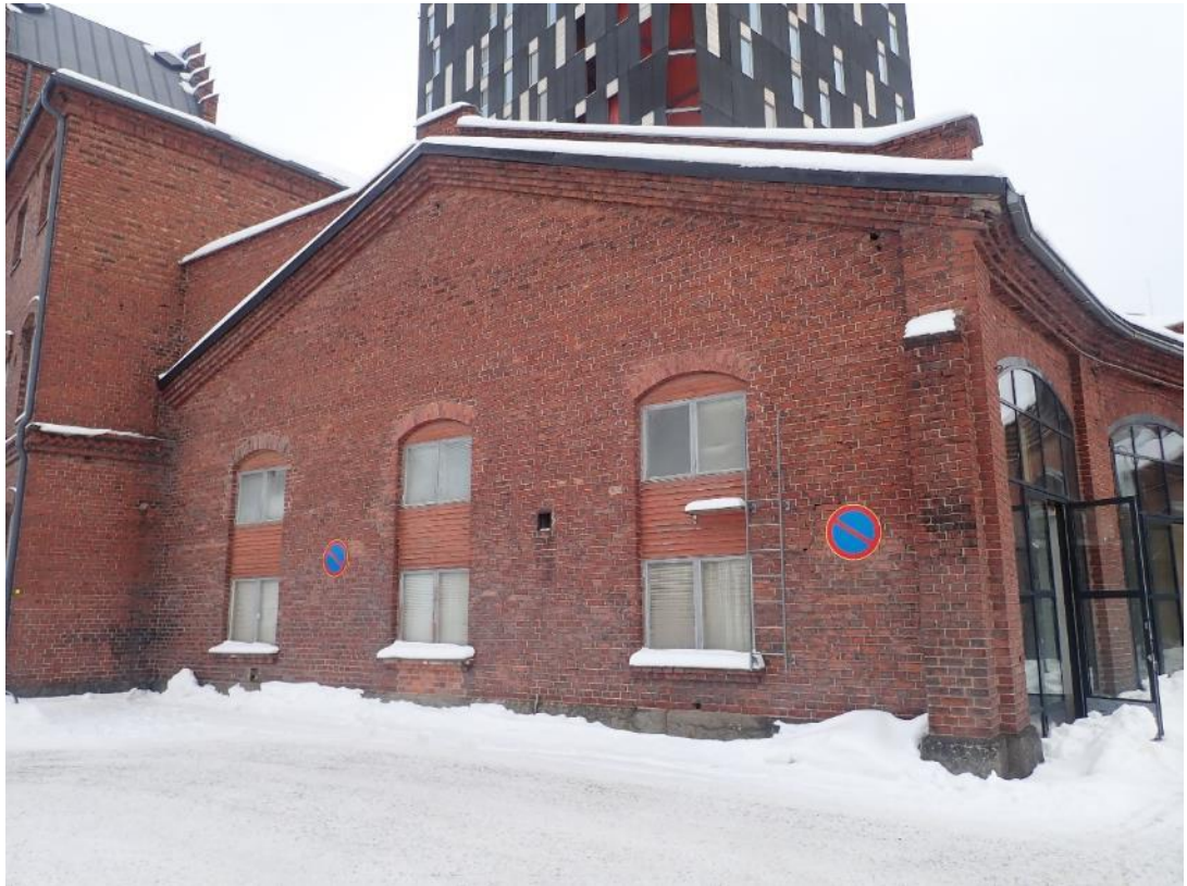
Kuva 2. Päätyjen ja sisäkaarteiden pihajulkisivun muuraus on yleisilmeeltään hyväkuntoisen näköinen.
