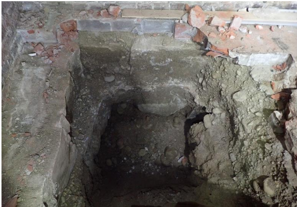
Kuva 18. Kaivanto 3, rakennusosa vuodelta 1897; pilttuu 7, itäinen ulkoseinä ja pilttuun 6 puoleinen väliseinä. Tiilimuurin alla on säännölliseksi työstettyjä luonnonkivilohkareita, jotka ulottuvat noin 160 cm syvyyteen lattiapinnasta. Lohkareiden alapuolella on soraa.
