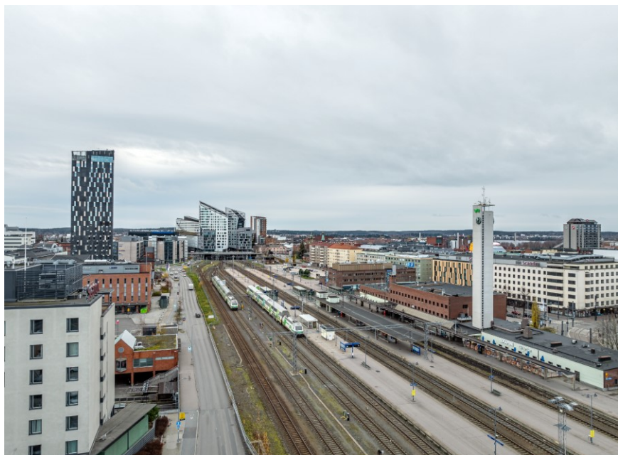
Kuva 3. Näkymä henkilöratapihan alueelle pohjoisen suunnasta. (Skyfox / Marko Kallio)
