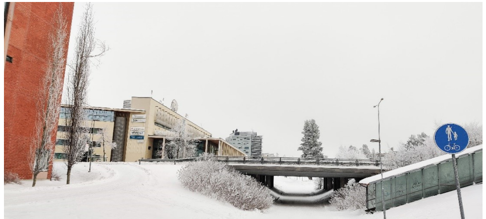
Kuva 25: Valokuva Ahvenniitynraitin alikulkukäytävästä, kuvattu tammikuussa 2021.
