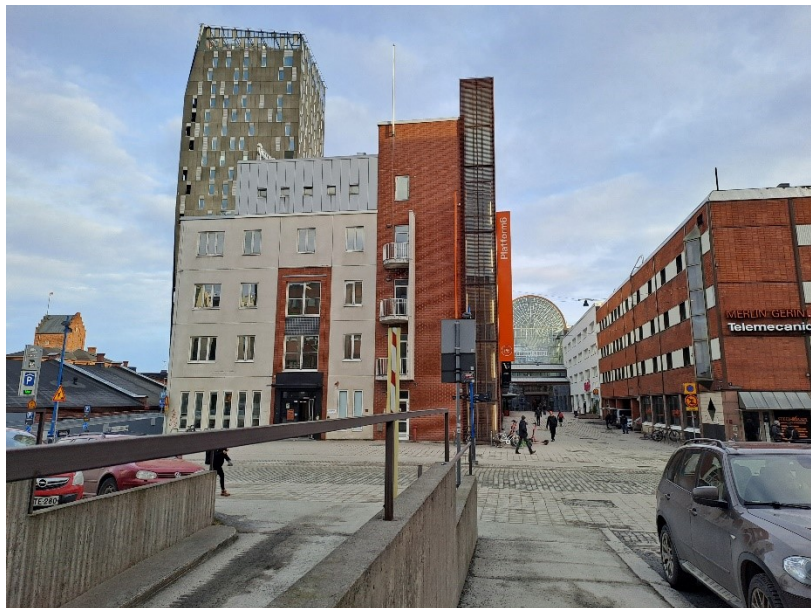
Kuva 10. Tullin alueen rakennuskantaa. Oikealla kujan päässä näkyy Tullintorin kaareva lasikatto. (Tampereen kaupunki 2025)
