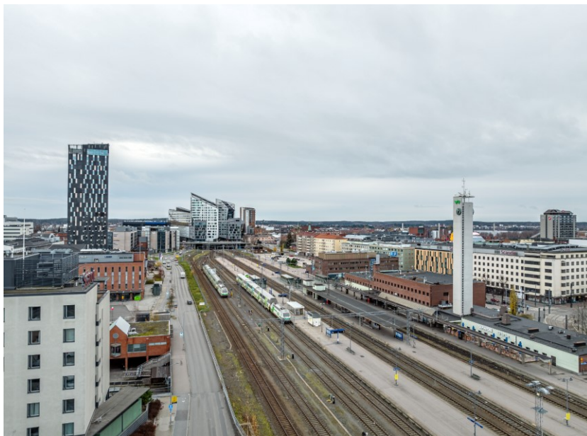
Kuva 43. Näkymä henkilöratapihan alueelle pohjoisen suunnasta. (Skyfox / Marko Kallio)
