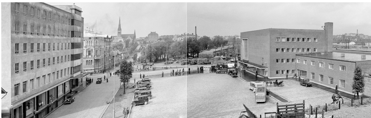
Rautatieasema ja asema-aukio sekä Hotelli Emmaus juuri valmistuneena vuonna 1936. Taustalla Tammelan sillan purku käynnissä. Panoraama kahdesta kuvasta. E.M.Staf. Vapriikin Kuva-arkisto
