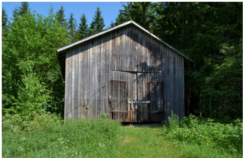
Kuva 8. Tilan muu rakennus. ©Tampereen kaupunki 2024
