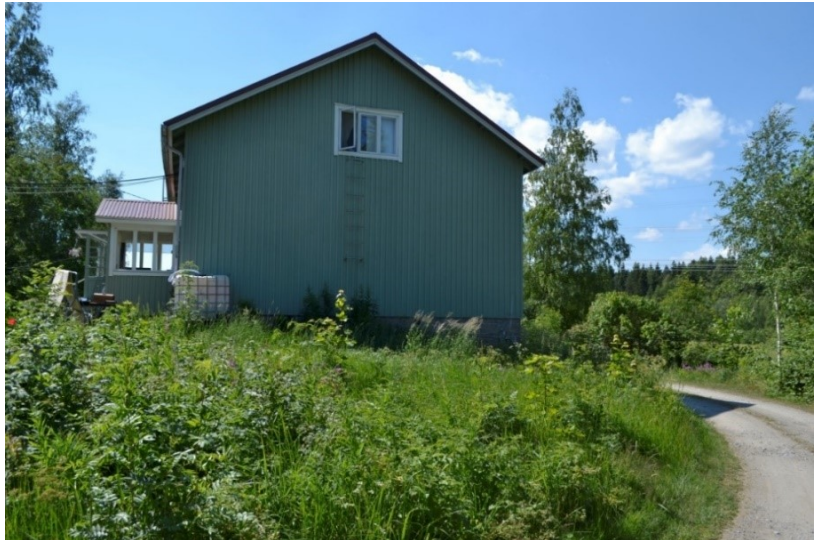
Kuvat 3 ja 4. Haapakorven tilan päärakennus. ©Tampereen kaupunki 2024
