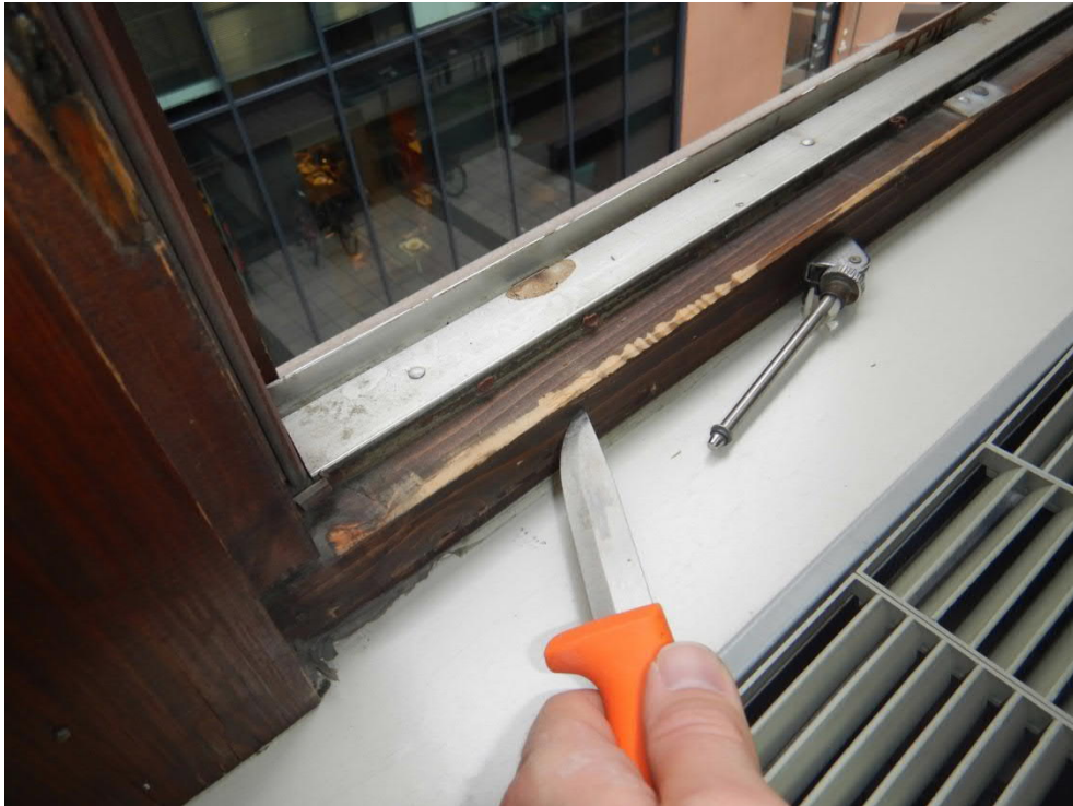
Kuva 33. Ikkunan puuosien kuntoa kokeiltiin puukolla. Laha ei havaittu.
