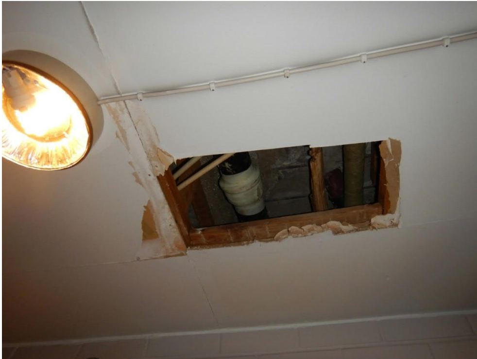
Kuva 19. Viemäriputken vuodon paikkaus näkyvissä.
