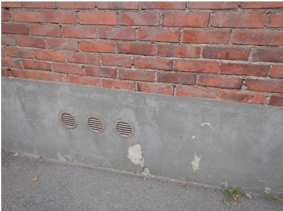
Kuva 4. Halkeama betonisokkelissa.
