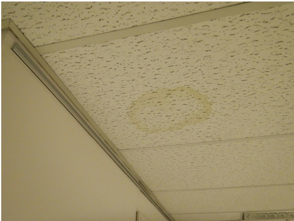
Kuva 20. Vuotojälki alakattolevyssä.
