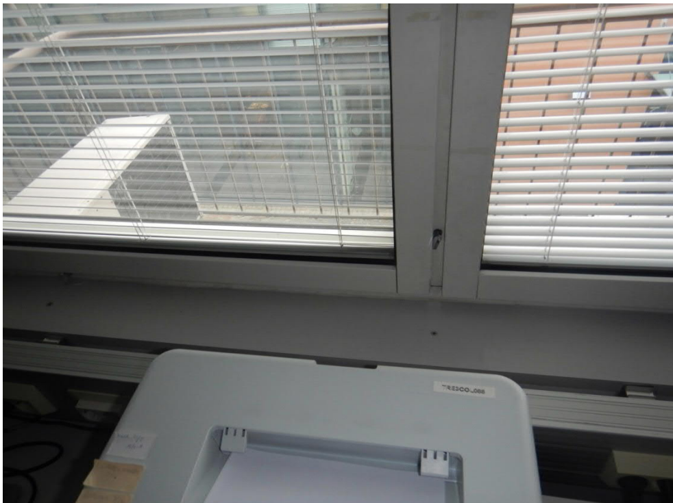
Kuva 34. Oletettavasti hieman uudempia ikkunoita asunto-osalla.
