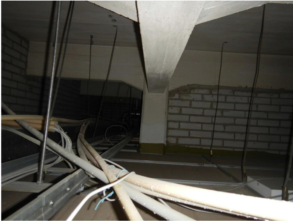
Kuva 39. Yleiskuva tehdasosan palkistosta alakaton sisältä.
