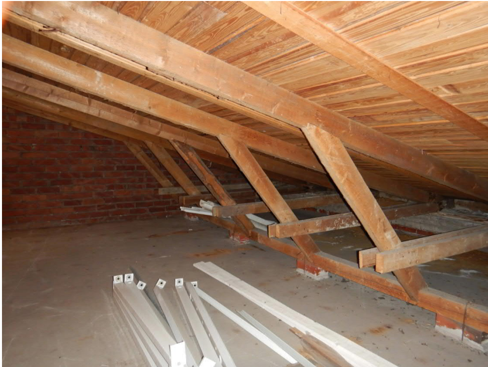
Kuva 35. Vesikaton kannatusrakenteita asunto-osan ullakon varastossa.
