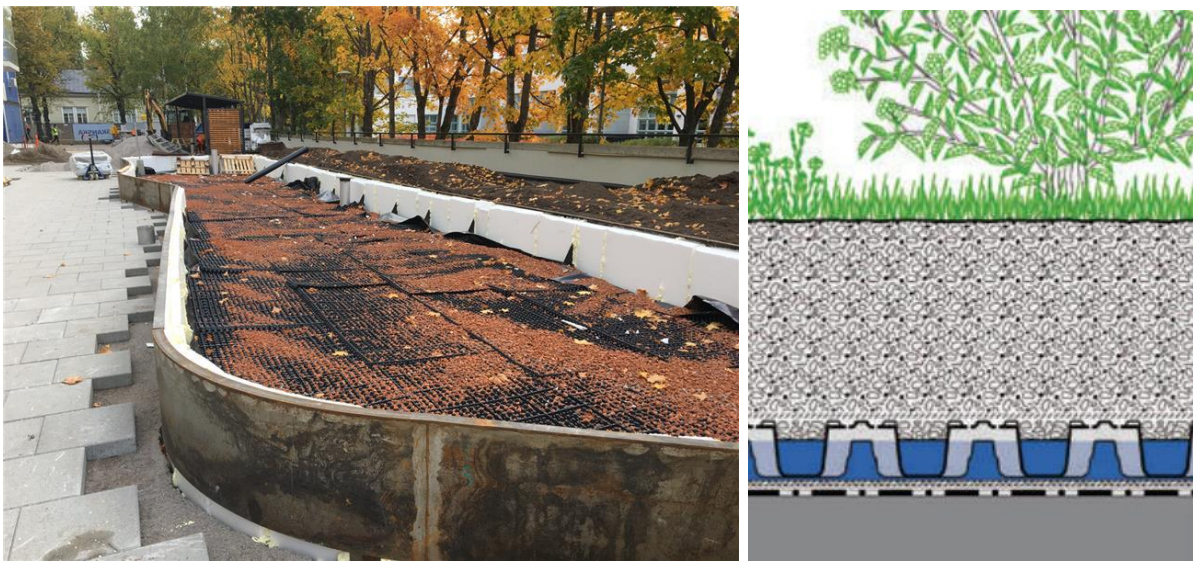
Kuva 7. Oikealla vettä varastoivan kennoston asentaminen ja vasemmalla kennostorakenteen periaatepoikkileikkaus 9 .
