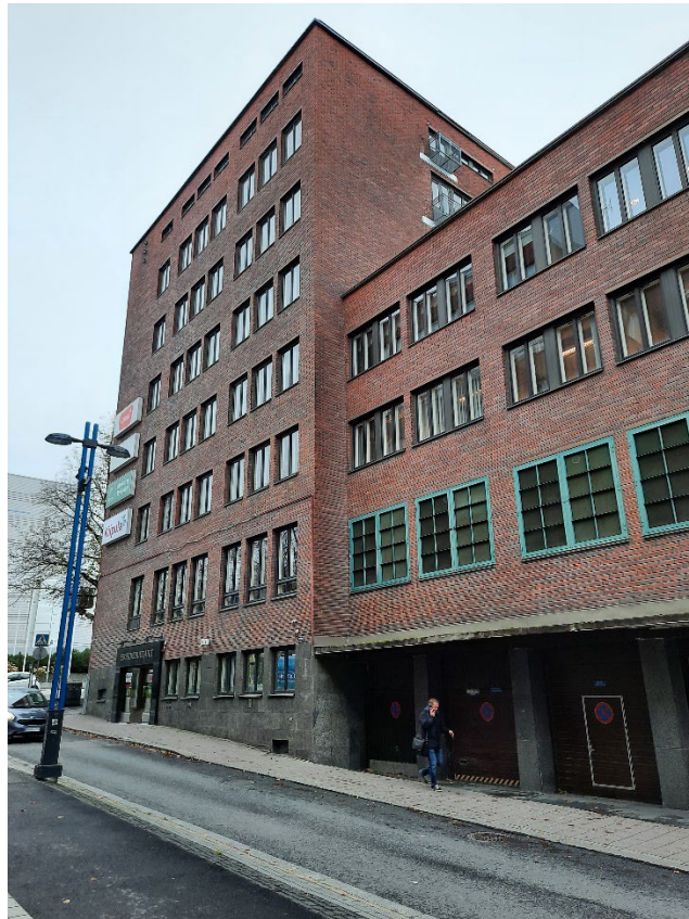
Kuva 2 Vasemmalla rakennusmassan pääosin säilyvä osa, oikealla purettava. Kuva Åkerlundinkadulta Tampere-taloa kohti.
