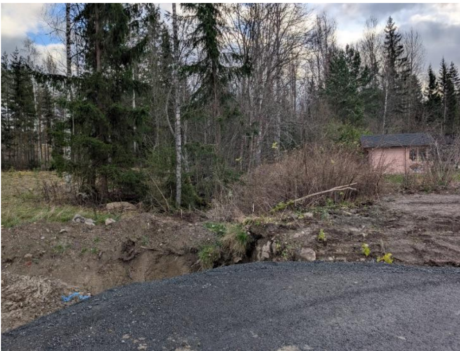
Kuva 25. Kuvan sijainti nro 16. Kuva uudelta tieltä muinaisjäännösalueen suuntaan etelään. Kuvassa oleva kaivanto on uusi salaoja.
