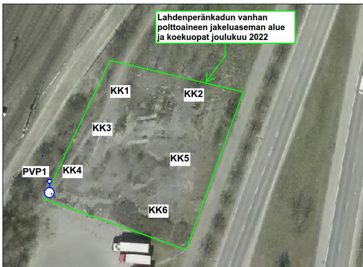
Kuva 3. Koekuoppien ja pohjavesiputken sijainti ilmakuvalla
