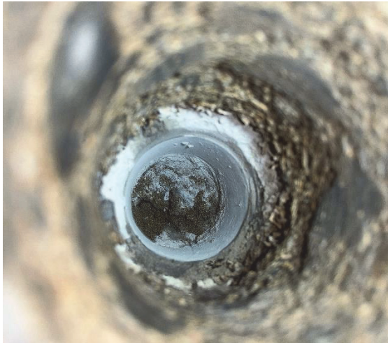
Alapohjan rakenteen avausta.
