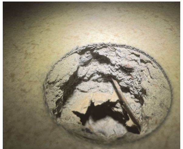
Välipohjan rakenteen avausta.
