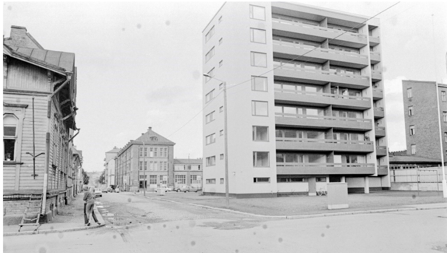
Kuva 11 Valokuva kerrostalosta vuodelta 1967 juuri sen valmistumisen jälkeen. Kuvan oikeassa reunassa näkyy kenkätehdas Solenan sisäpihan siipi. Vasemmassa reunassa ja taustalla näkyvät rakennukset on purettu ja nykyään tilalla on asuinkerrostaloja. (Vapriikin kuva-arkisto)
