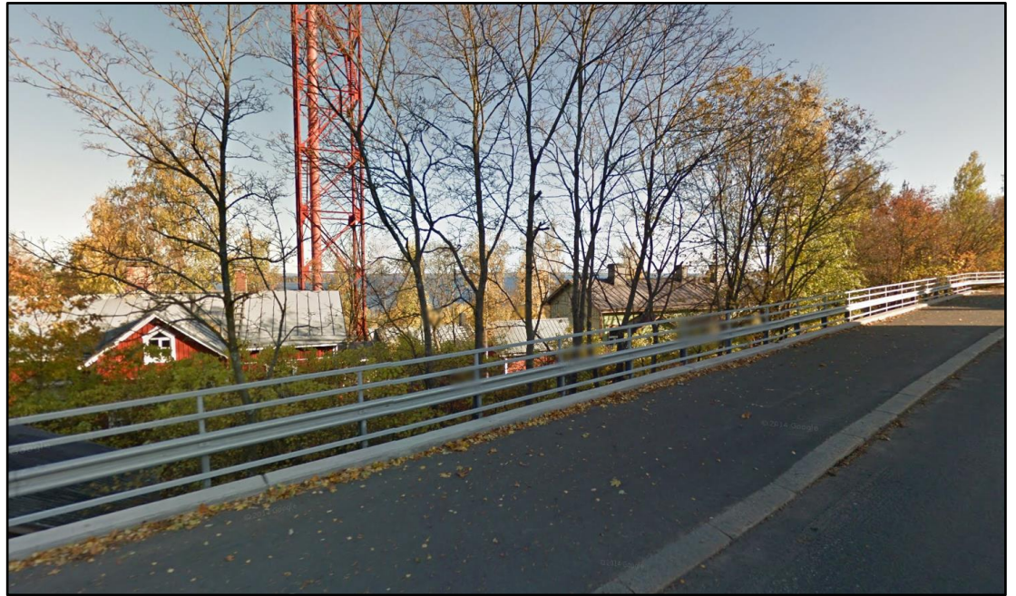
Kuva 6. Haulitorin korttelin kohdalla nykytilanteessa sijaitseva kaide.
