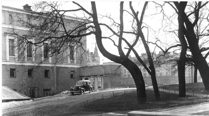
Kuva 10 Arkistokuva teatterin pohjoispuolelta ennen 1980-luvun muutostöitä ja laajennusta. Tampereen teatteri rakennushistoriaselvitys, s.194.
