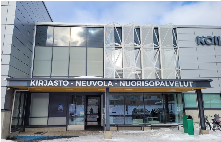
Koilliskeskuksessa on Prisman lisäksi myös julkisia palveluita
