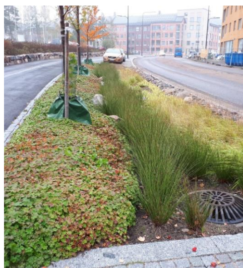
Kuva 1. Läpivirtaava kitakansisto Mossin puistokadulta, jolla ajoradan vesiä ohjataan reuna-alueelle + valmis suodatuspainanne Kuninkaantammessa (Ramboll).
