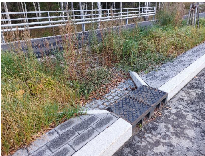
Kuva 1. Läpivirtaava kitakansisto Mossin puistokadulta, jolla ajoradan vesiä ohjataan reuna-alueelle + valmis suodatuspainanne Kuninkaantammessa (Ramboll).
