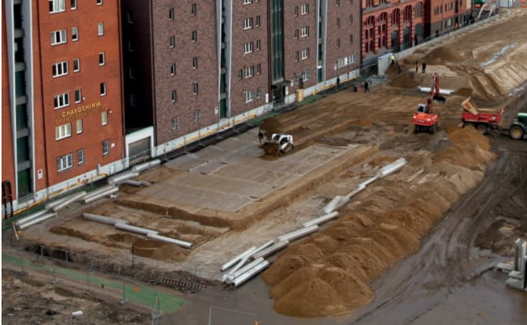
Kuva 6.8 Geolujitetun pengerpaalutuksen rakentamista kaupunkialueella Hampurissa, Saksassa. (S. van Eekelen & M. Brugman 2016)
