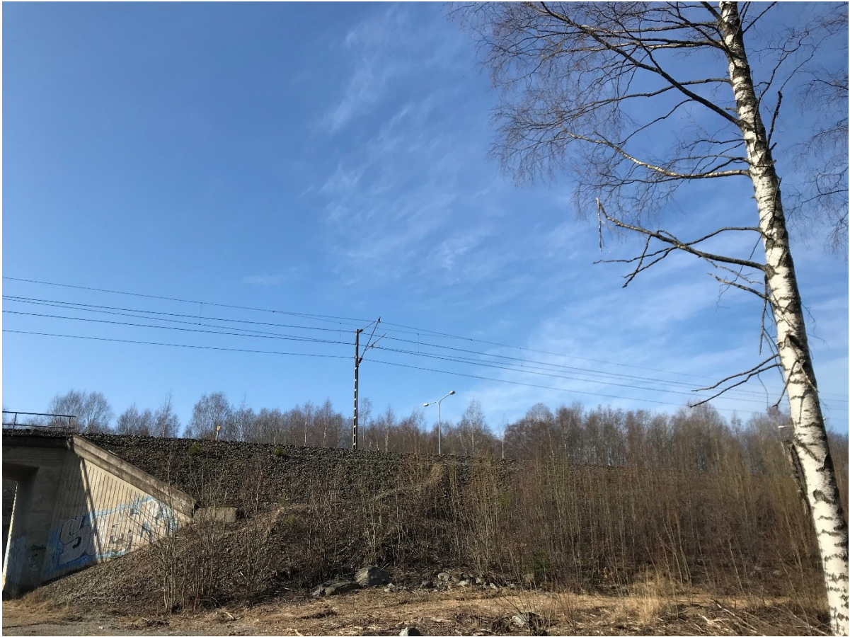
Kuva 8-7 Lähtöaineiston mukainen kulkuyhteys Ryydynpohjassa. Kuva Vaasantien itäpuolelta.
