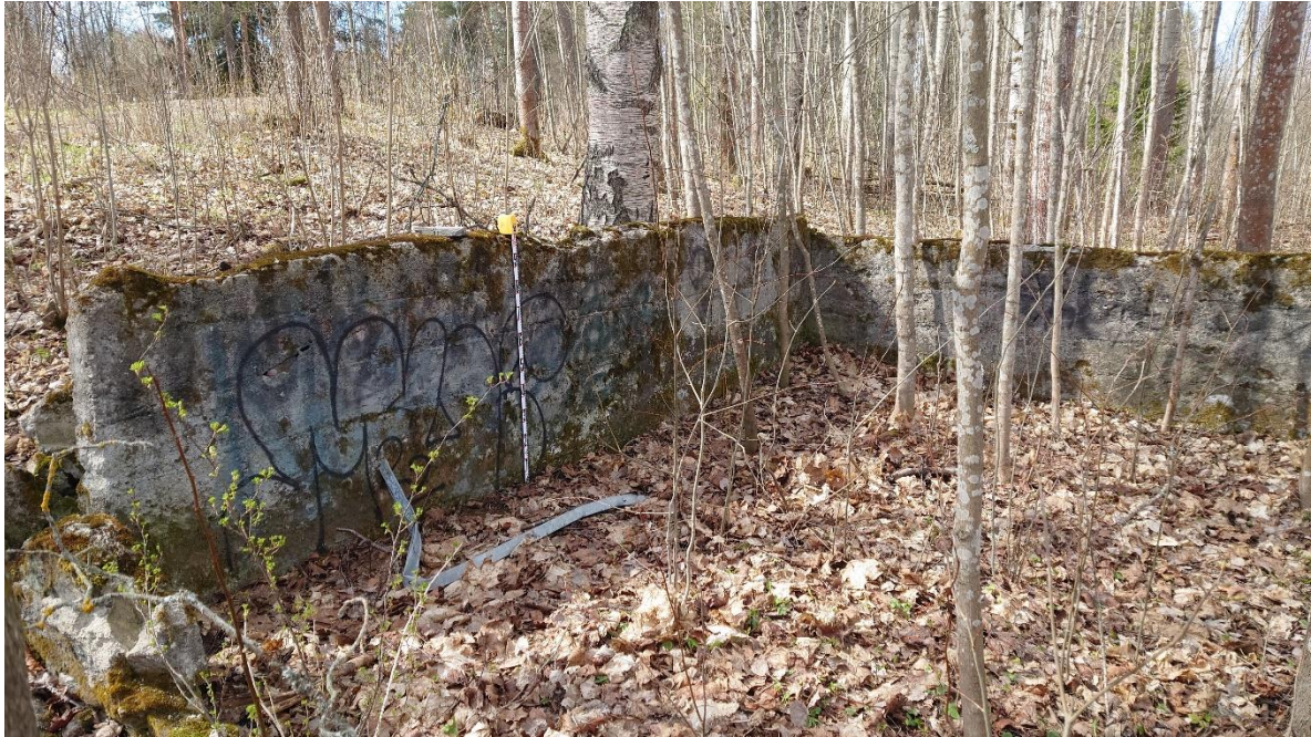
Kuva 7. Betonirakenne Ristimäen torpan lähistöllä.
