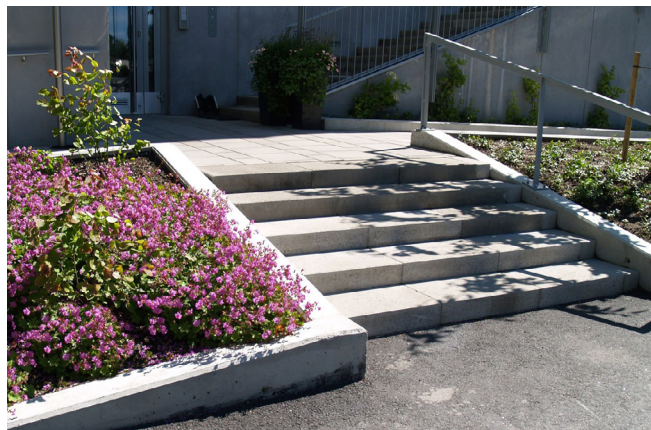
Kuva 30. Harmaalla betonikivellä toteutetut portaat. Rudus.
