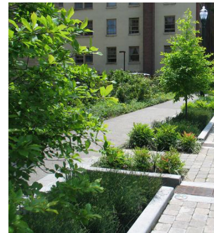
Kuva 70. Yllä: Hulevesien ohjaamista alaslasketuille istutuksille aukotetun reunakiven hulevesikaivon kautta. Alla: Vedet ohjataan istutukselle reunakiven aukosta. Kuvat: Anna Levonmaa
