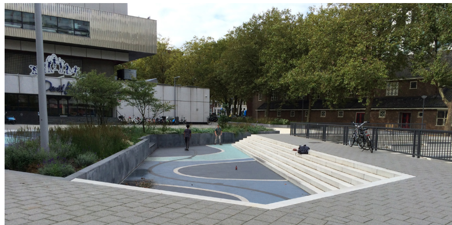
Kuva 66. Tulvanhallintaa varten rakennettu viivytysallas, jota voi hyödyntää kuivana aikana esimerkiksi skeittaamiseen.
