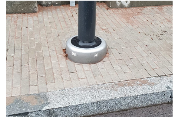
Kuva 39. Esimerkki siististi viimeistellystä pylvään asennuksesta kivettyllä jalkakäytävällä, jossa on käytetty TER-osaa jalustassa.
