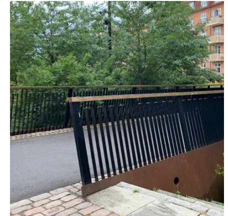
Kuva 28. Laadukas silta hulevesipuistossa puisella käsijohteella. Kuva: Anna Levonmaa
