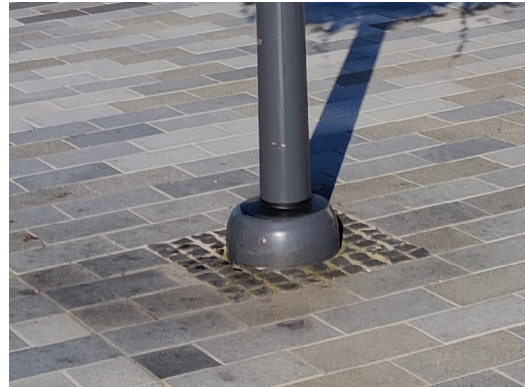
Kuva 38. Esimerkki siististi viimeistellystä pylvään asennuksesta aukiolla Espoon Kauniaisista, jossa on käytetty maalattua TER-osaa jalustassa.
