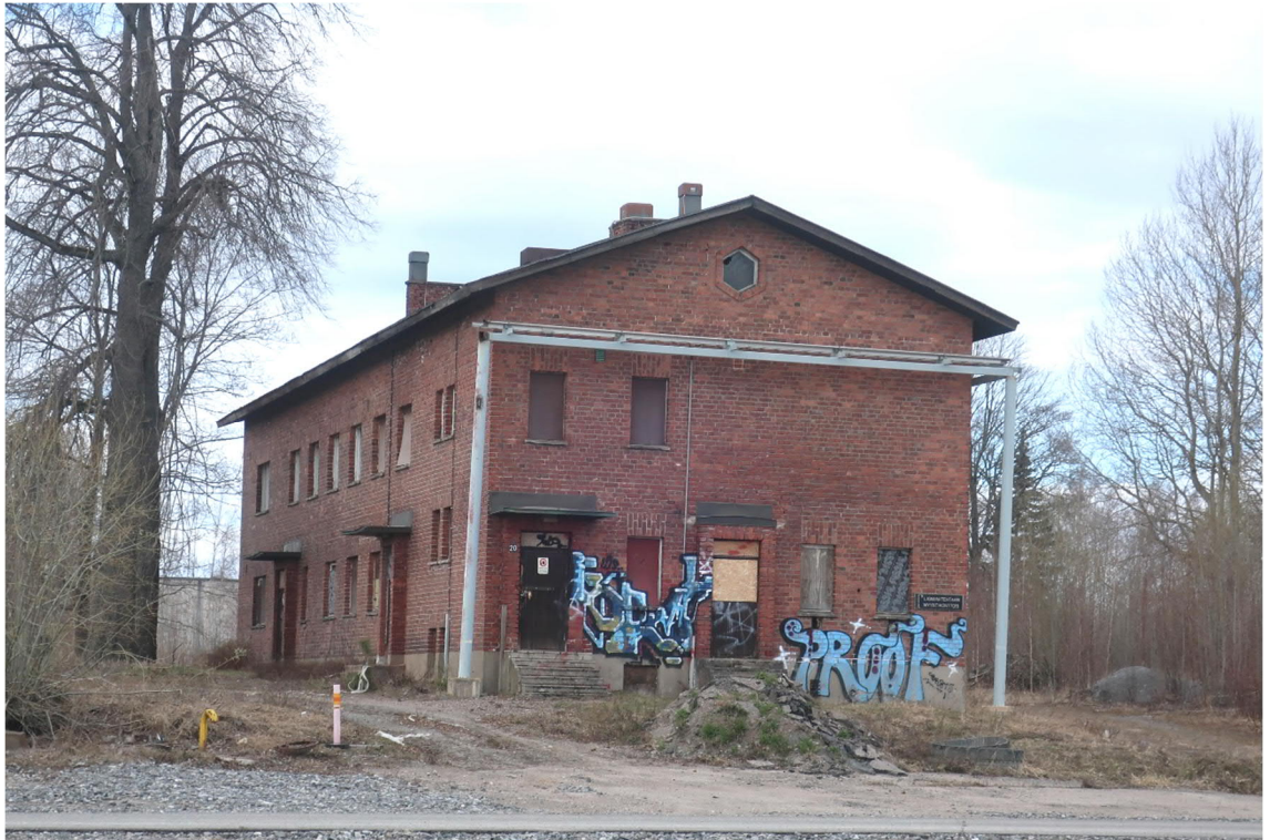
Kuva 2. Yleiskuva rakennuksen kaakkoispäädystä/etelänurkalta.
