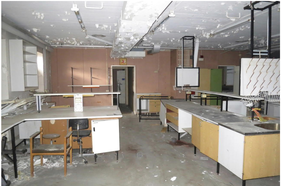
Kuva 3. Yleiskuva rakennuksen 1. kerroksen tilasta 104.
