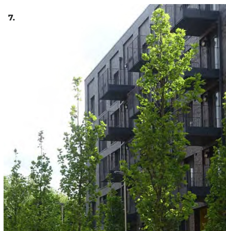
Ulokeparvekkeet ja parveke-elementit puiston puolella
