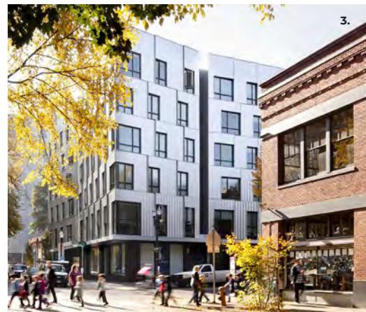
Toimisto- ja työpaikkarakennukset Paasikiven suuntaan
