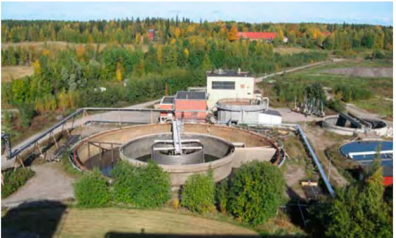
Jätteenkäsittelyä varten rakennettiin 1970-luvun aikana tehtaan koillispuolisen liettealtaan (entinen järvenlahti) länsipäähän liettämö puhdistusaltainen sekä jätteenpolttolaitos. 2000-luvun alussa alueelle on lisätty kaksi mikroflotaatiolaitesuoja. Kuva M Real.
