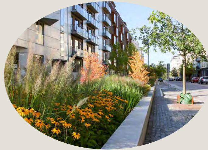
Kadun ja korttelin välinen alue on perinteisempää rakennettua ympäristöä. Tällä alueella metsäisyys ei näy yhtä paljon. Kuvassa rakennuksen ja kadun välinen korotettu istutusallas, johon johdetaan kattovedet.
