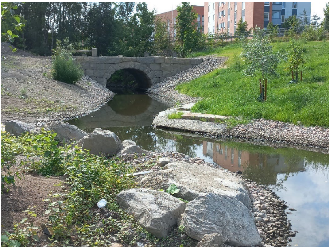
Kuva 19. Härmälänojan putkitus avattuna.
