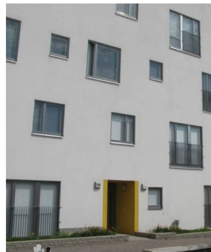
Heleä tehosteväri sisäänkäyntisyvennyksessä. Kuva: Tampereen kaupunki.
