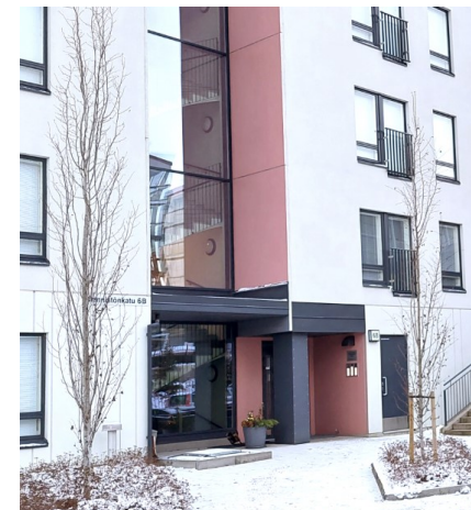
Sisäänkäynti ja porrashuone syvennyksessä. Kuva: Tampereen kaupunki.
