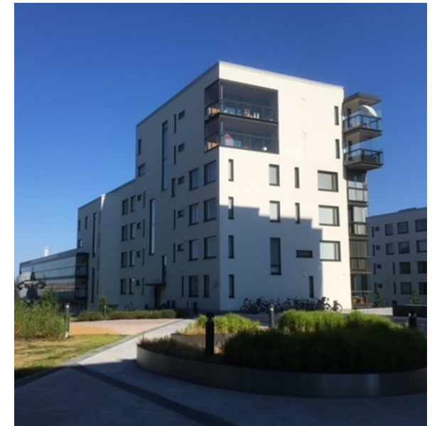
Modernia vaihtelevaa ikkunajaotusta pistetalomaisessa rakennuksen osassa. Kuva Tampereen kaupunki.
