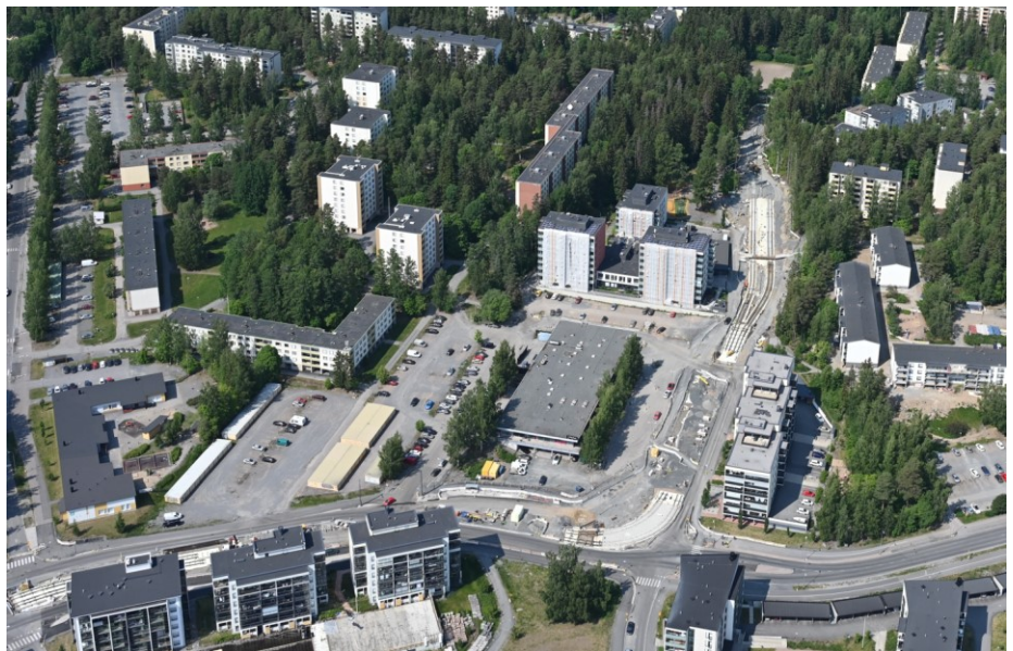
Kuva 1. Viistokuva kesältä 2023. Etualalla raitiotielinjan työmaa. Kuva: Suomen ilmakuva Oy.
