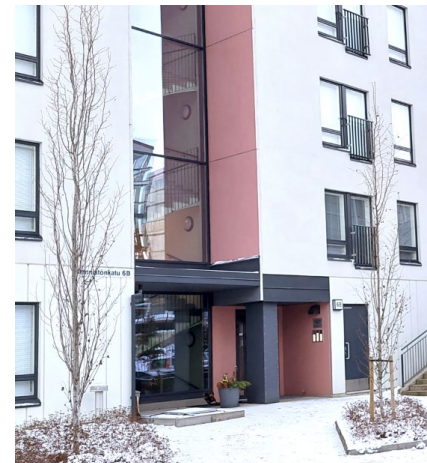
Sisäänkäynti ja porrashuone syvennyksessä. Kuva: Tampereen kaupunki.
