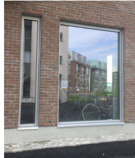
Ikkunallinen pyörävarasto katujulkisivussa. Kuva: Tampereen kaupunki.
