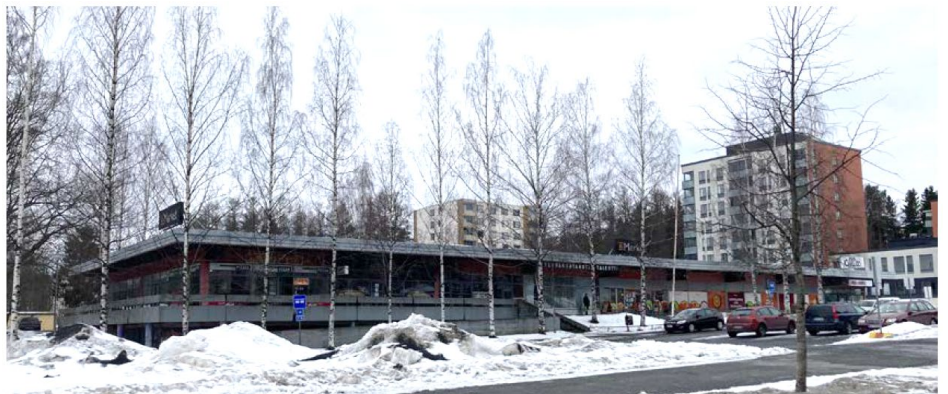
Kuva 7: Liikekeskus kaakon suunnasta. Kuva Rakennushistoriallinen selvitys, Arkkitehtitoimisto Neva Oy.
