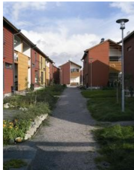
Asunto Oy Porvoon Jokineidon pihan pinnoitteet ovat vettä läpäiseviä, Arkkitehtioimisto Tuomo Siitonen Oy © Kimmo Räisänen
