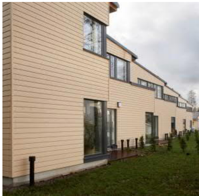
Pitkän rakennusmassan asunonkohtainen porrastaminen. Ketjutalo Törmäpääsky © Asta Björklund, Risto Iivonen Arkkitehdit Oy, kuva Kimmo Räisänen.
