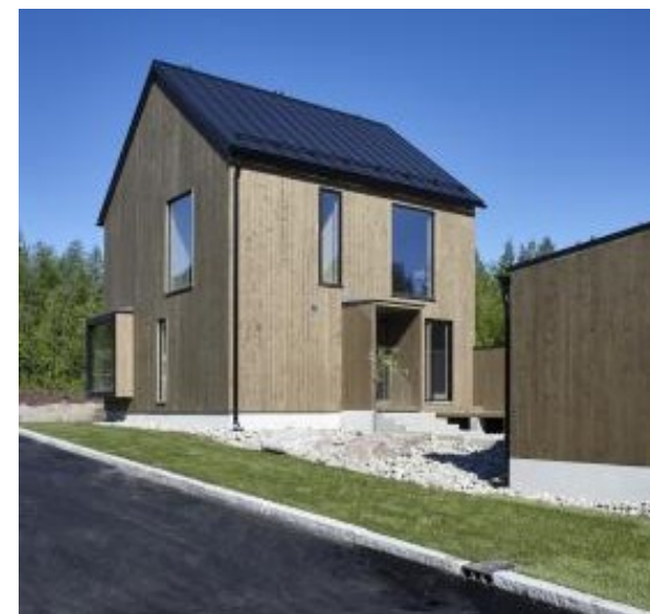
Kotola © Arkkitehti Takkunen
