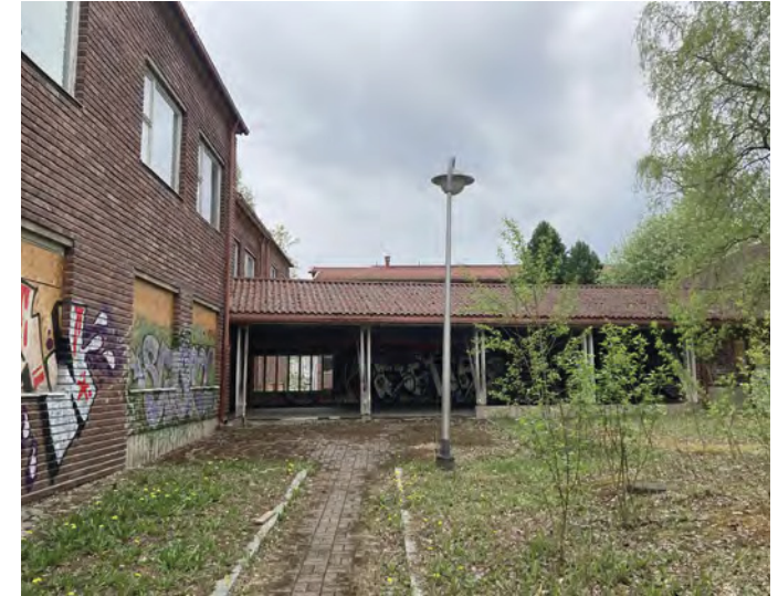
Rakennukset yhdistävä katos ja vanha valaisinpysäkö.
