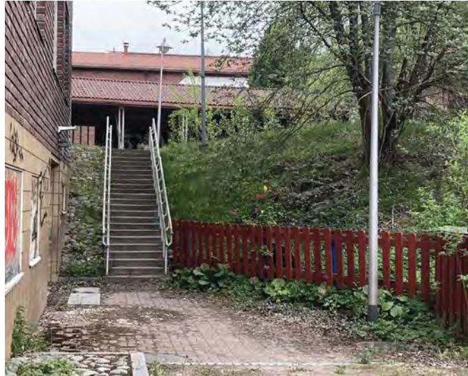
Kulkuväylä rakennuksen koilliskulmalta yläsisäpihalle.
