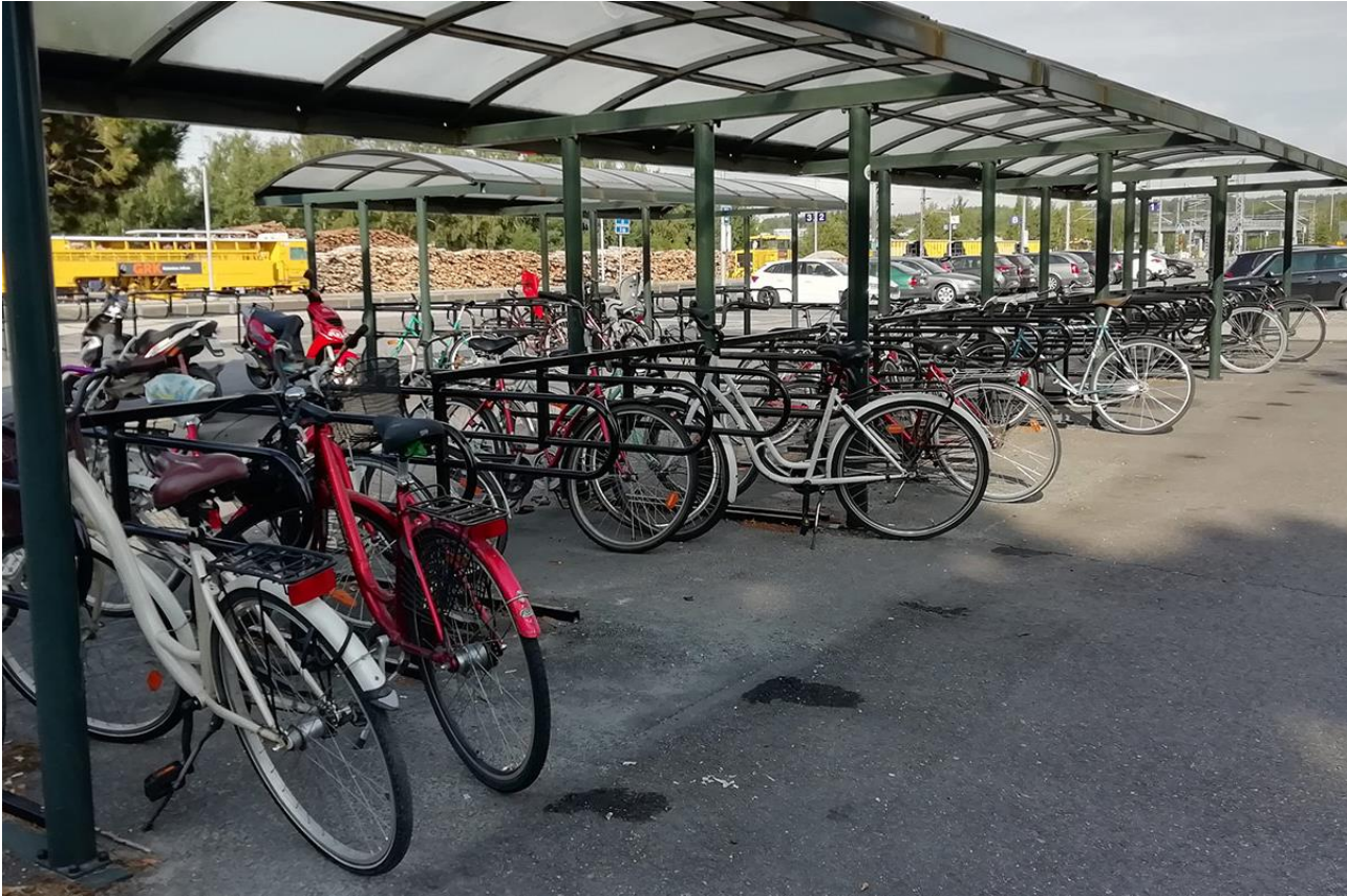
Laadukas pyöräpysäköintipaikka on katettu ja runkolukittava. Kuva: Salon rautatieasema, Väylävirasto
